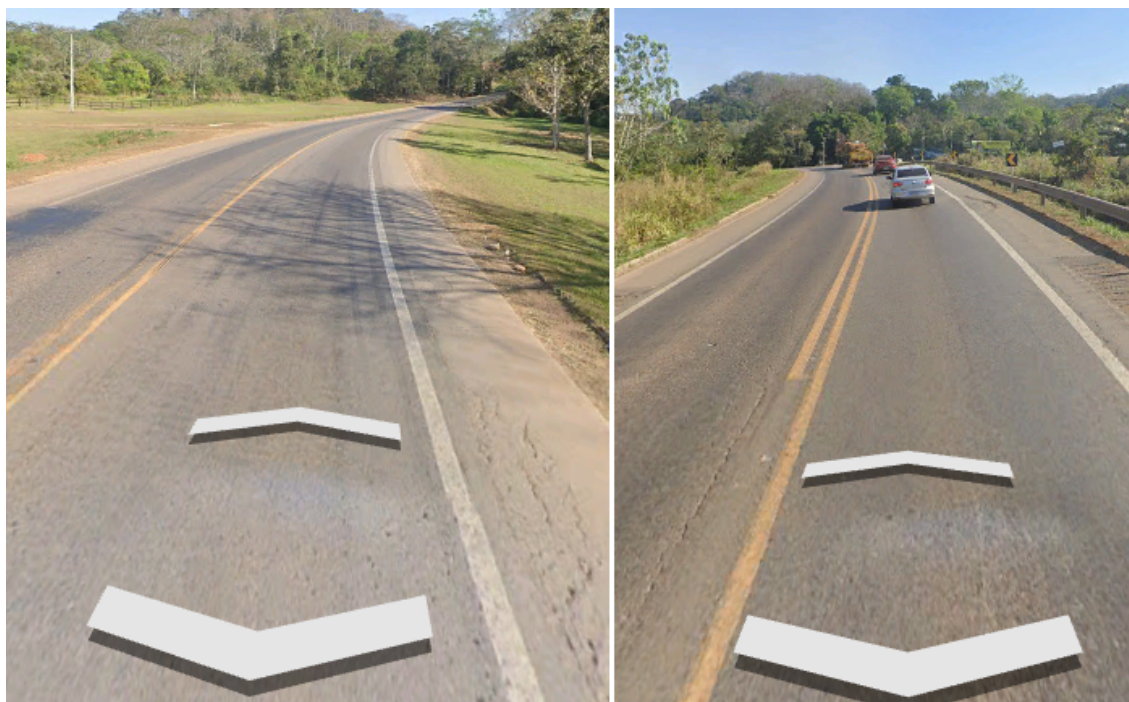
Figura 9: Correções de curvas horizontais em trechos de raio longo – Km 5.386 e 5.385 do projeto
