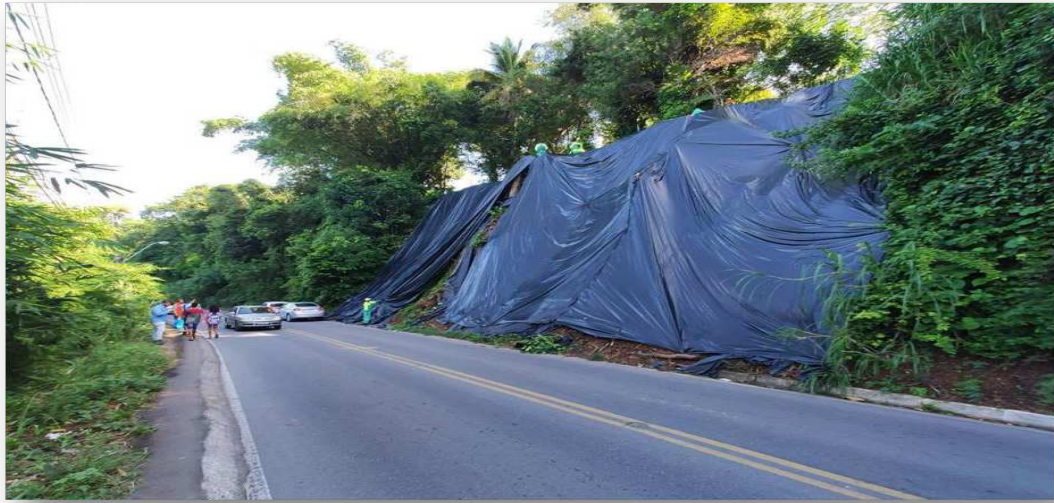
Figura 04 – Encosta com proteção da lona plástica
