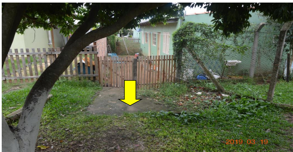
Figura 23 – A rede no final da Rua Mário Lessa, observar a tampa da caixa de passagem no passeio.
