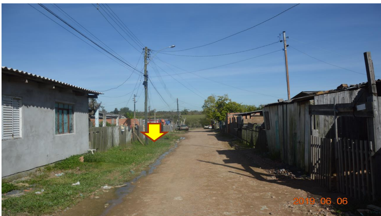
Figura 65 – Rua 16, bairro São Jorge, segundo moradores a mais de 10 anos, a água já chegou ao ponto demarcado.
