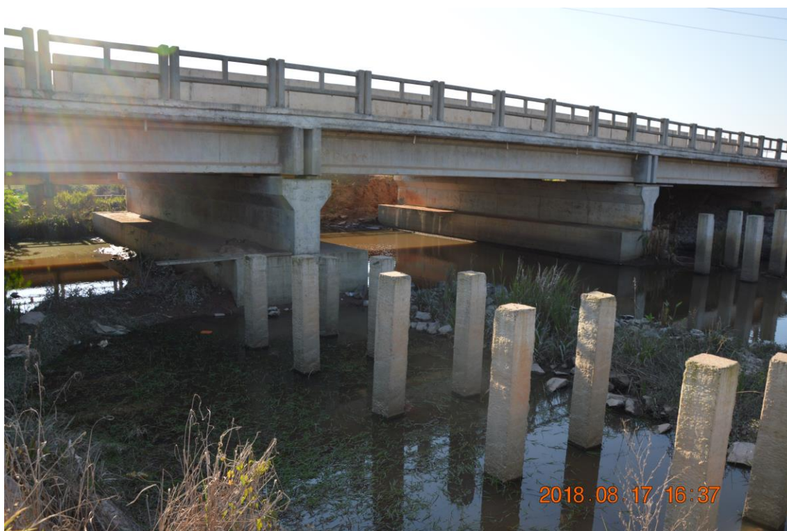
Figura 19 – Vista das fundações da segunda ponte da duplicação da BR/116.
