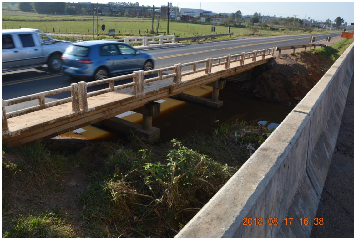
Figura 18 – Vista da Rodovia BR/116, pontes existentes.
