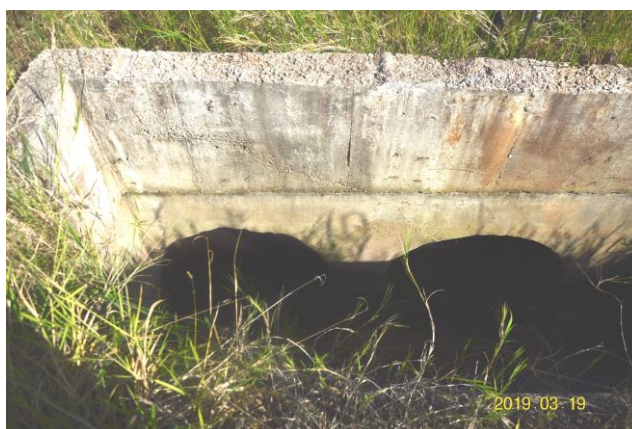
Figura 58 – BTTC 1,2 – margem da BR/116 – km 302+690
