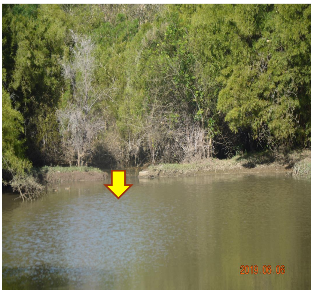
Figura 63 – Local do extravasor do barramento as margens dos Loteam. Recanto dos Pássaros 1 e 2.
