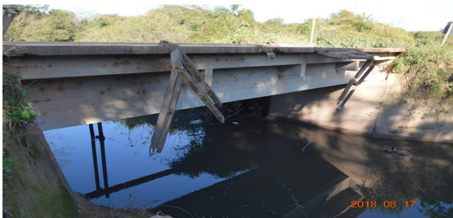
Figura 15 – Nova ponte construída ao Longo da Estrada Geral – Arroio Passo Fundo
