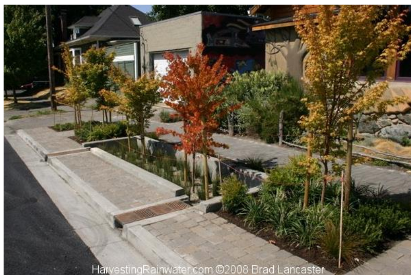
Figura 35 – Nova concepção de micro drenagem
