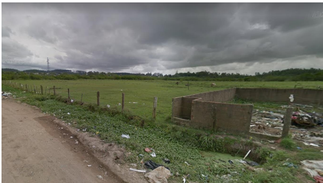
Figura 27 – Ponto de tomada na rua B - PV100
