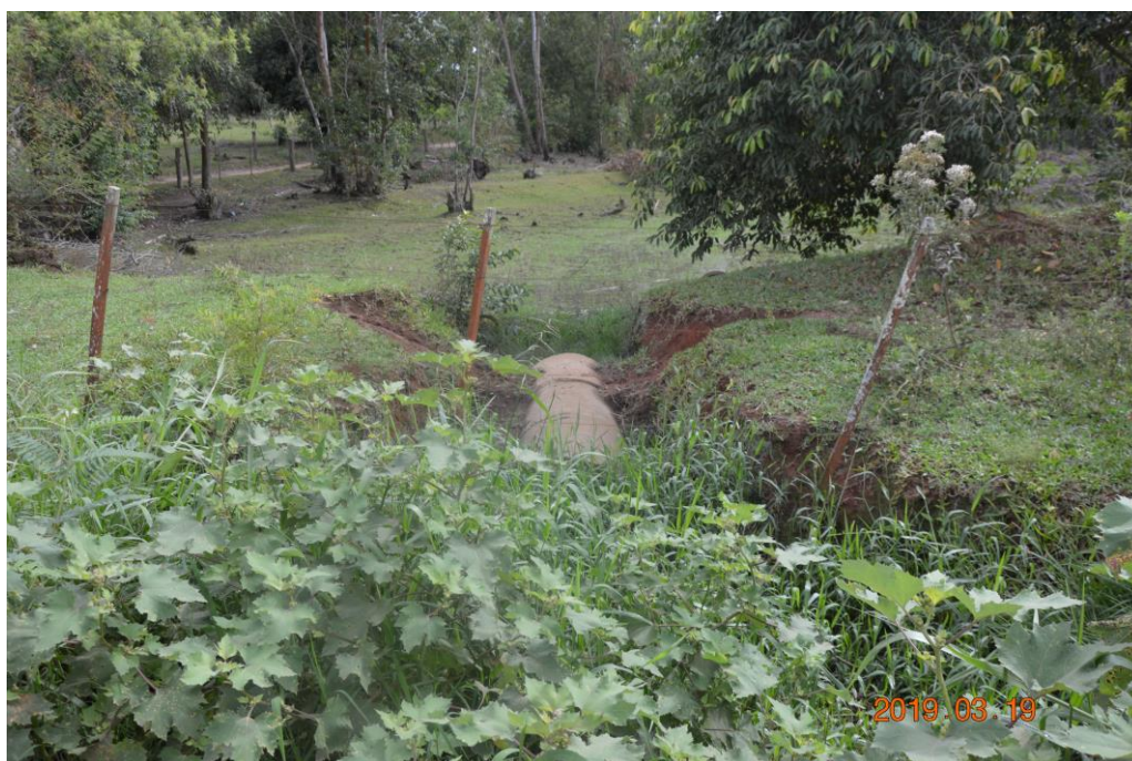
Figura 25 – Deságue da rede em terreno não edificado na Rua Seu Sereno.
