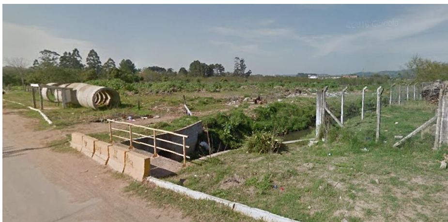
Figura 28 – Destino final da macro drenagem existente das sub-bacias 1 e 2. Rua D com Av. das Indústrias.
