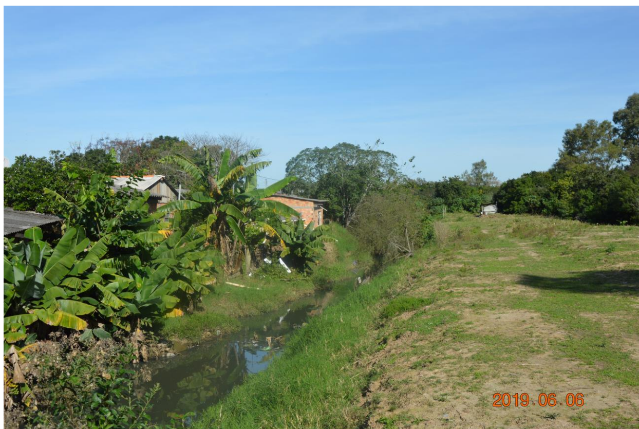
Figura 78 – Trecho E-F existente.
