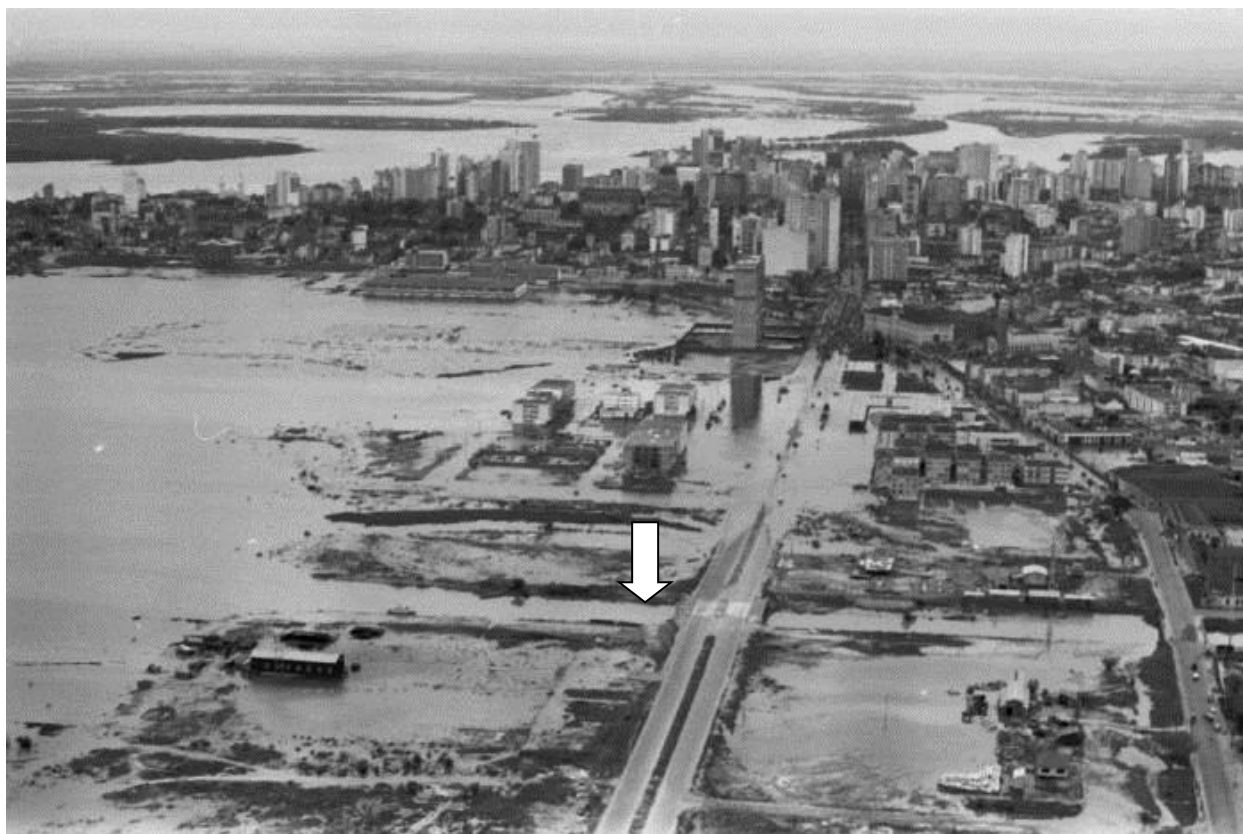
Figura 9 – Vista da região do porto (cheia 1967)– fonte acervo fotográfico Zero hora. Na seta o Arroio Dilúvio.
