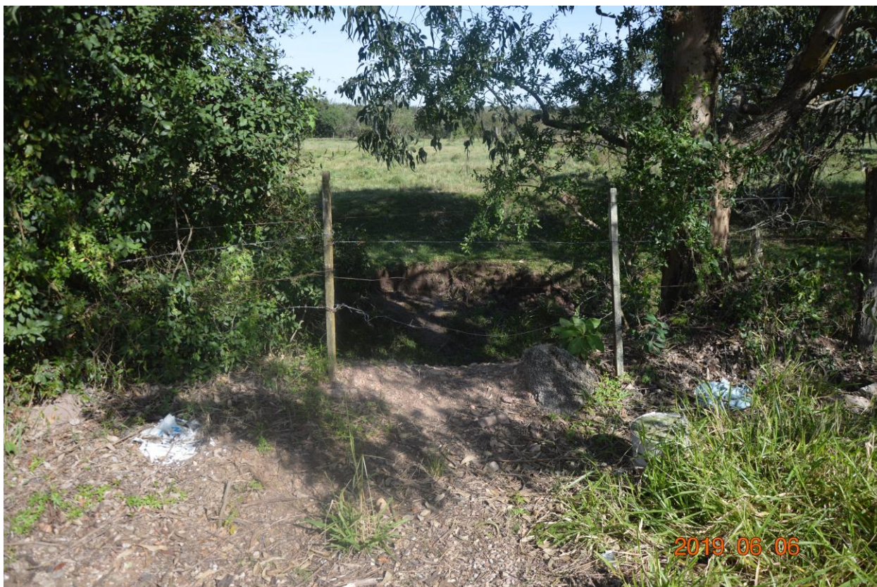
Figura 76 – Valeta existente – Trecho C-B.
