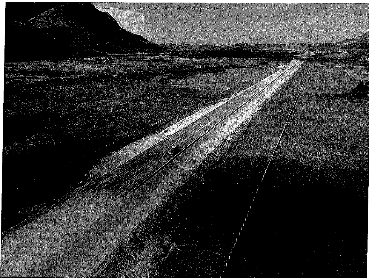
Foto 03 – Vista geral da estaca 450 (terraplenagem em estágio avançado, preparando para início da pavimentação).
