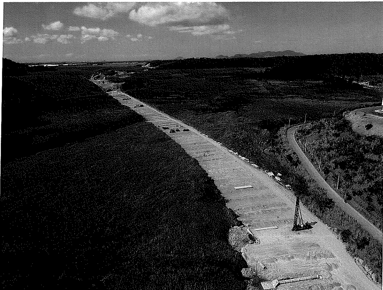
Foto 04 – Vista geral da via elevada 03 (estacas arrasadas, preparadas para início dos blocos de c
