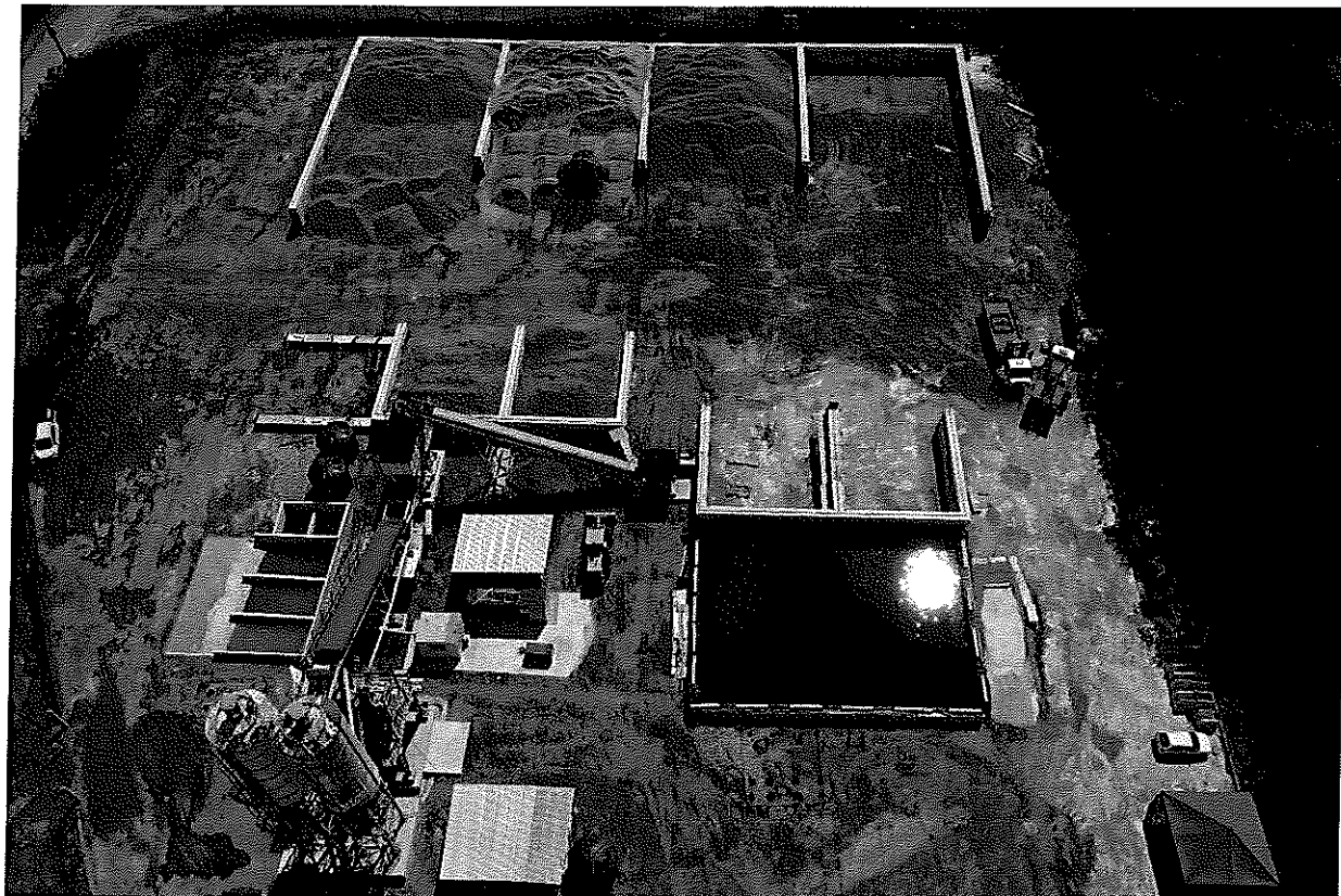
Foto 01 – Vista geral da central de concreto instalada no canteiro de obras.
