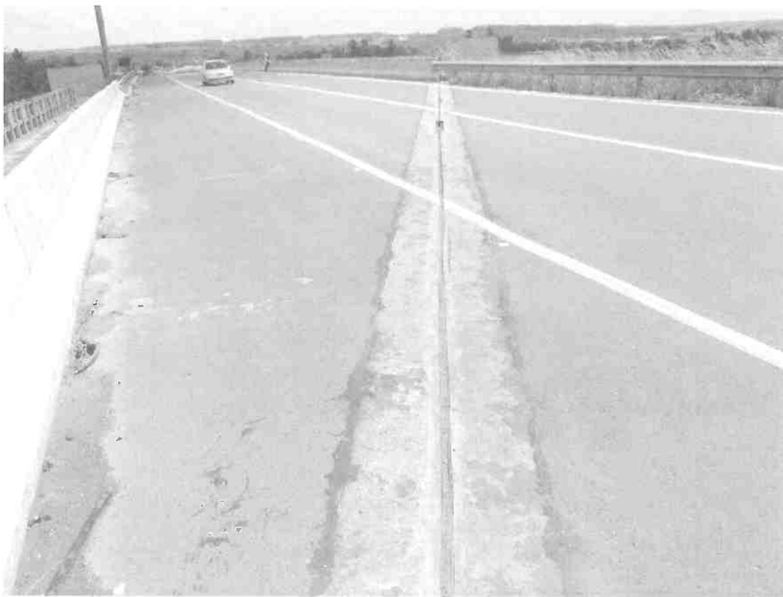
Junta elastomérica de dilatação no encontro E 2
