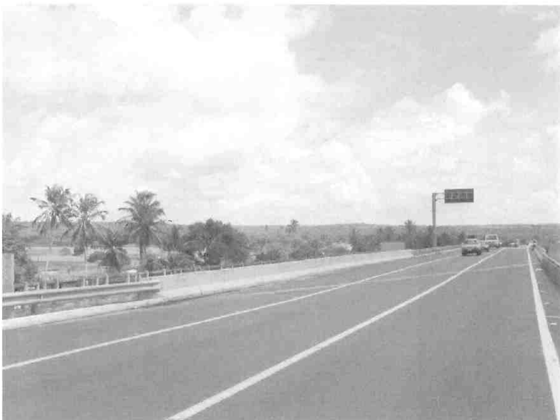
Calçada para pedestre de concreto armado obstruída/ Barreira new jersey
