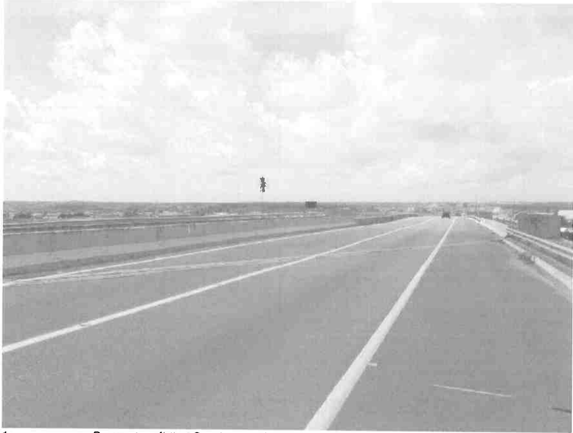
1 Pavimento asfáltico/ Guarda corpo de concreto armado
