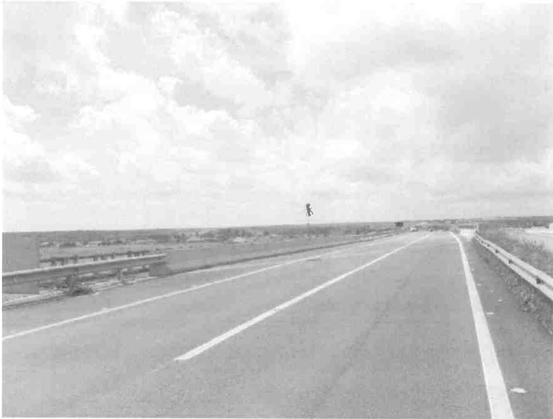
1 Vista Geral Superior do encontro E-1 ( TOUROS / DIVISA RN / PB )
