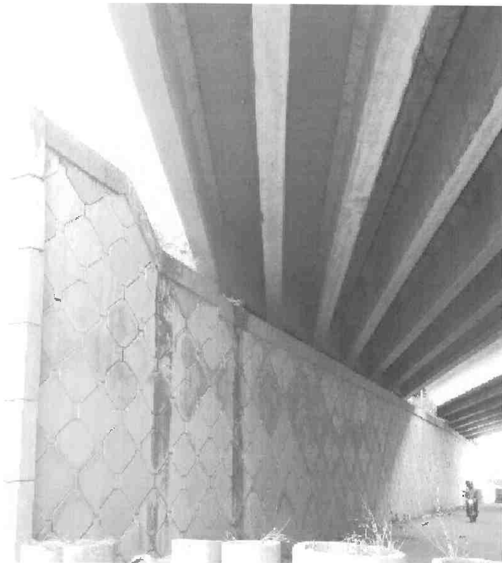
Muro de terra armada - Infiltração
