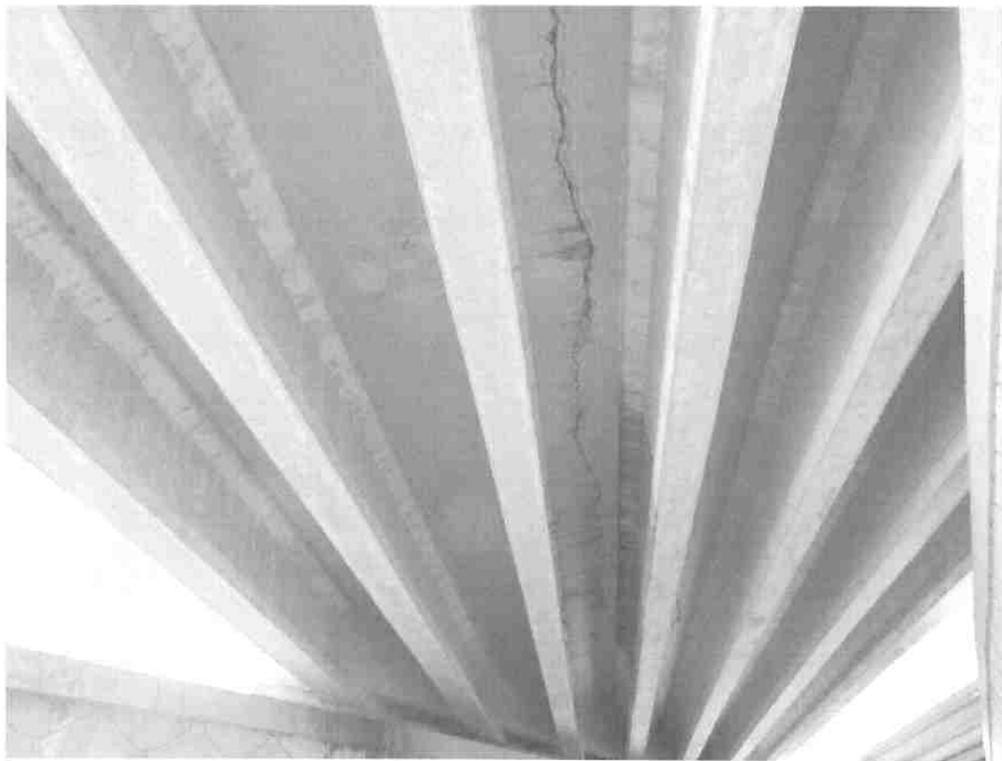
Laje de concreto armado/ Viga T ou I de concreto armado
