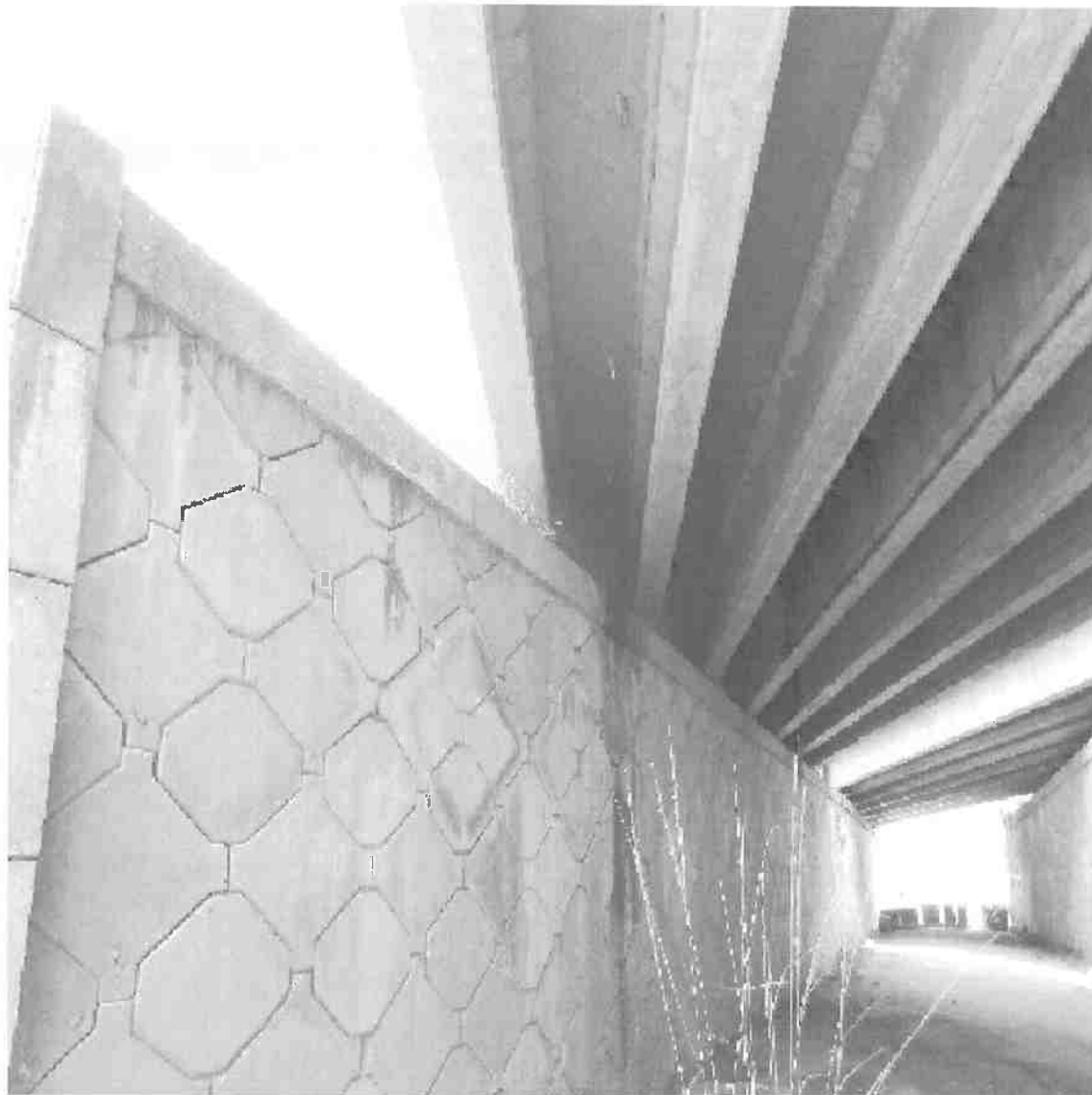
Muro de terra armada - Infiltração
