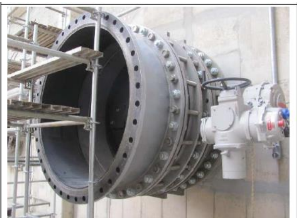
Foto 13: WBS 2610 – Vista interior da EBV-1 com da válvula borboleta hidráulica da bomba 1 em 13 de junho de 2014.
