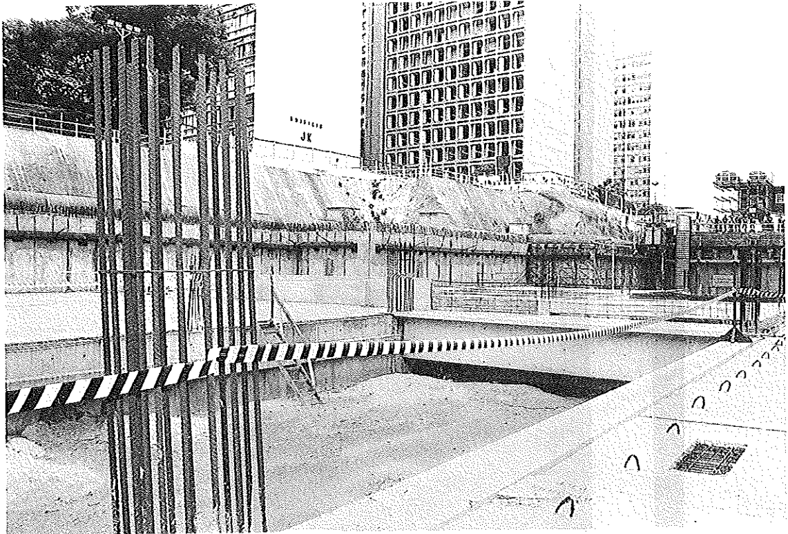
Metrô do Distrito Federal
