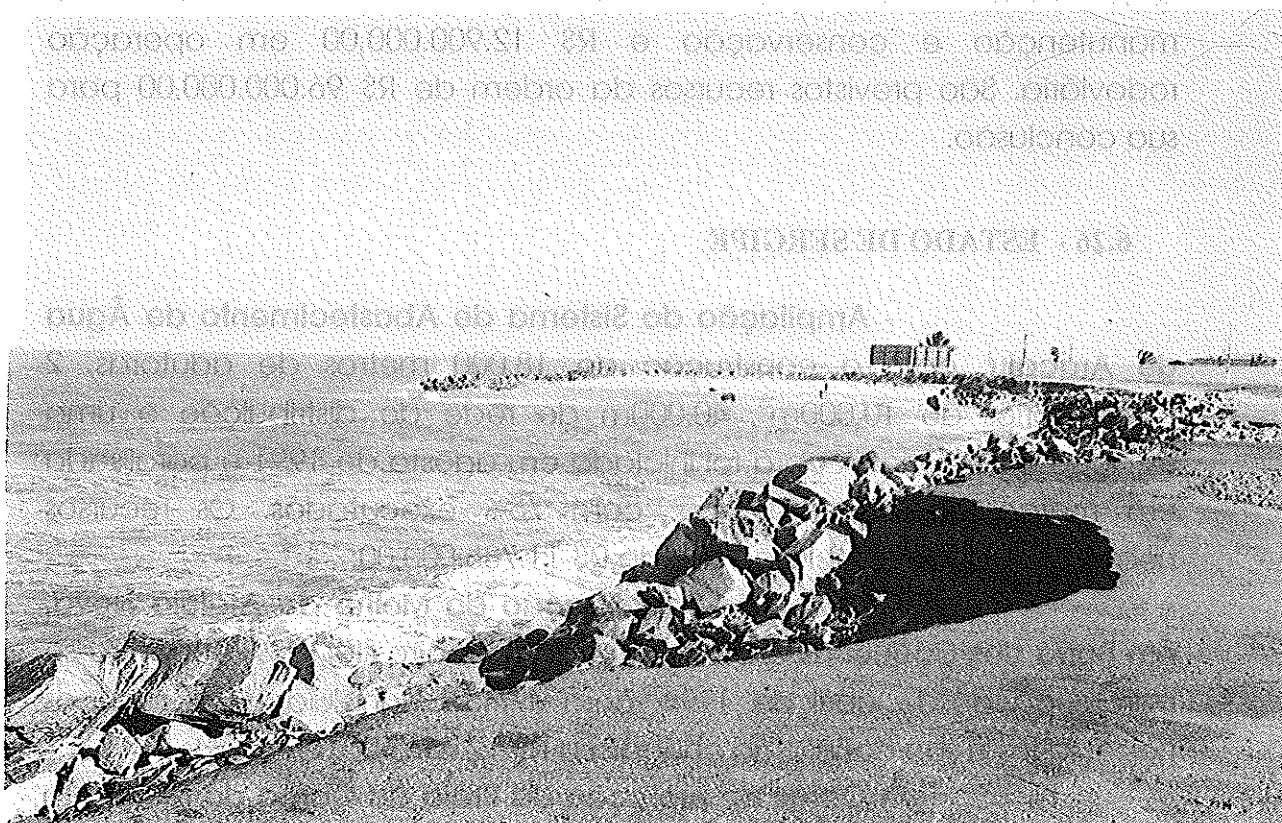
Obra de proteção da Praia da Coroa do Meio em Aracajú-SE
