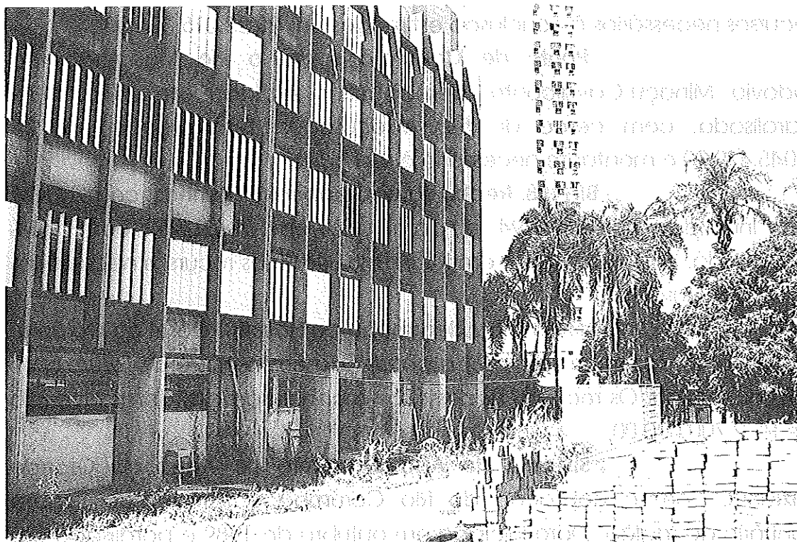
Reforma e adequação do Hospital Geral de Goiânia - GO
