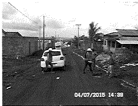
ALTAMIRA TESTE DA REDE DE ESGOTO
