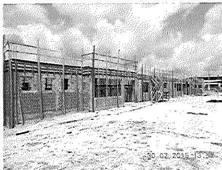
VITÓRIA DO XINGU CONSTRUÇÃO DE HOSPITAL MUNICIPAL
