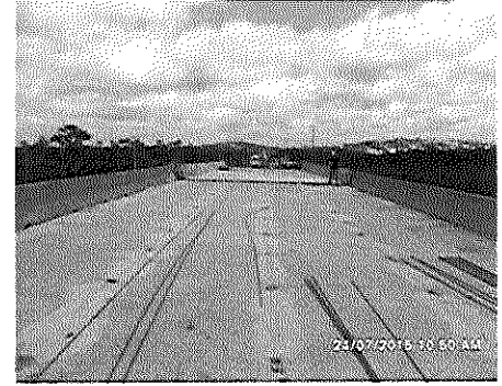
ALTAMIRA PONTE SOBRE O IGARAPÉ AMBÉ - TRANSAMAZÔNICA
