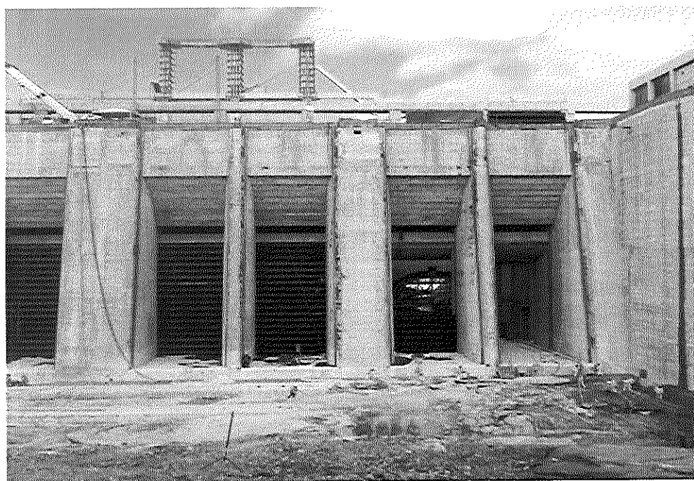
Sítio Pimental – Tomada d'água – Vista à montante TA-03 – Finalizada a Concretagem de guias e grades da Comporta Ensecadeira
