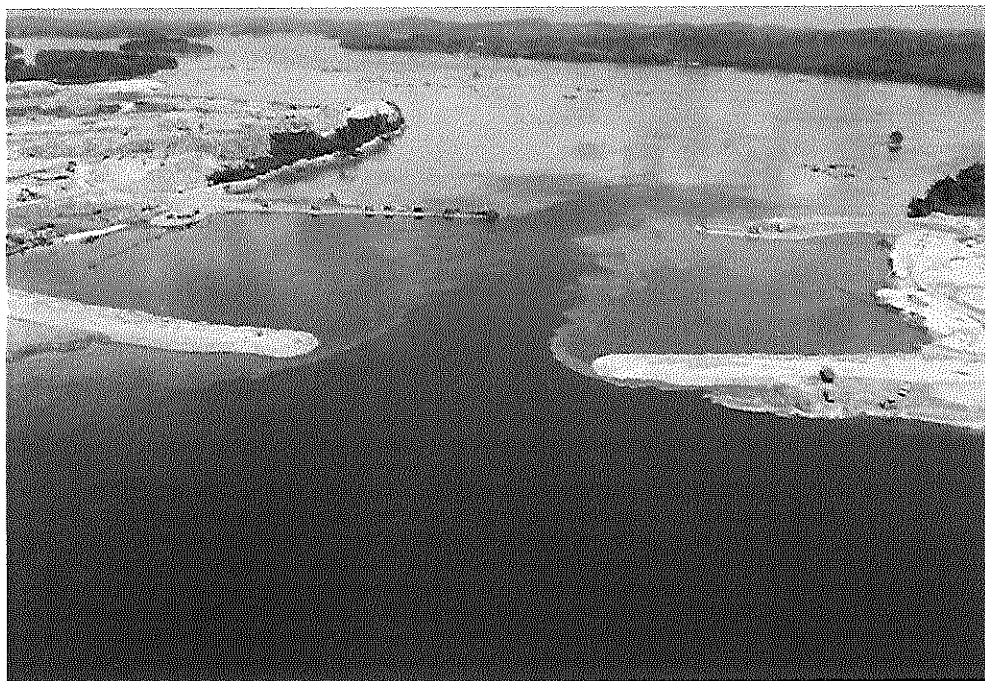
Sítio Pimental – Avanço da Pré-ensecadeira de Montante
