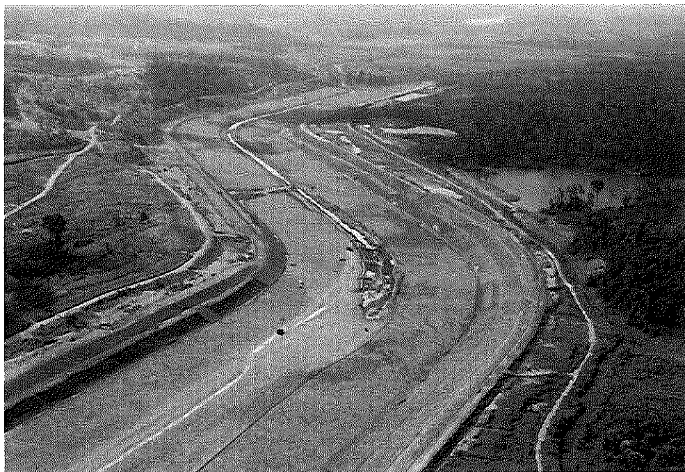
Canal de Derivação – Km 18,5 ao km 20,0 - Vista geral do revestimento dos taludes e fundo do Canal
