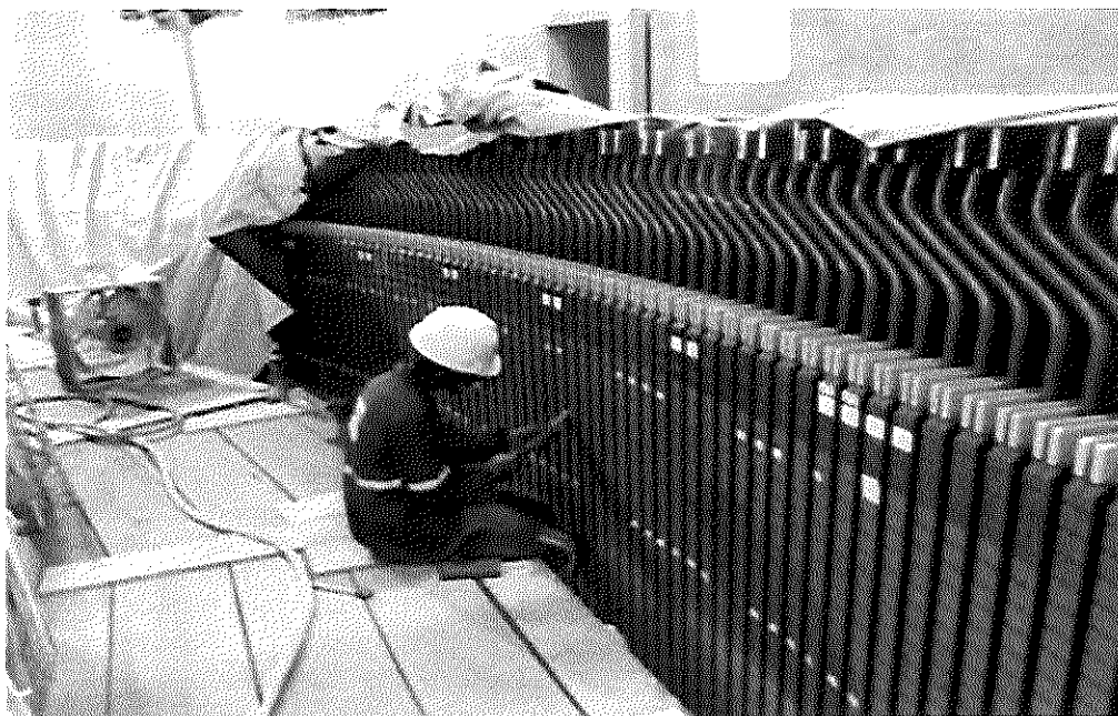
Sítio Belo Monte - UG01 Montagem das barras do Estator.
