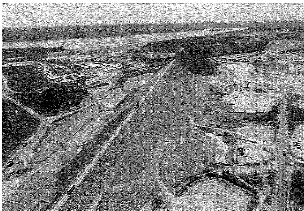
Sítio Belo Monte – Barragem de Fechamento Esquerda
