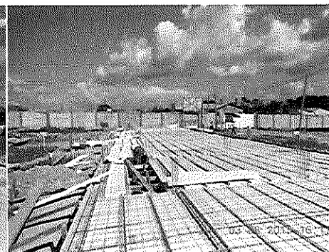
ANAPU CONSTRUÇÃO DE EMEI E EMEF SÃO LUIZ
