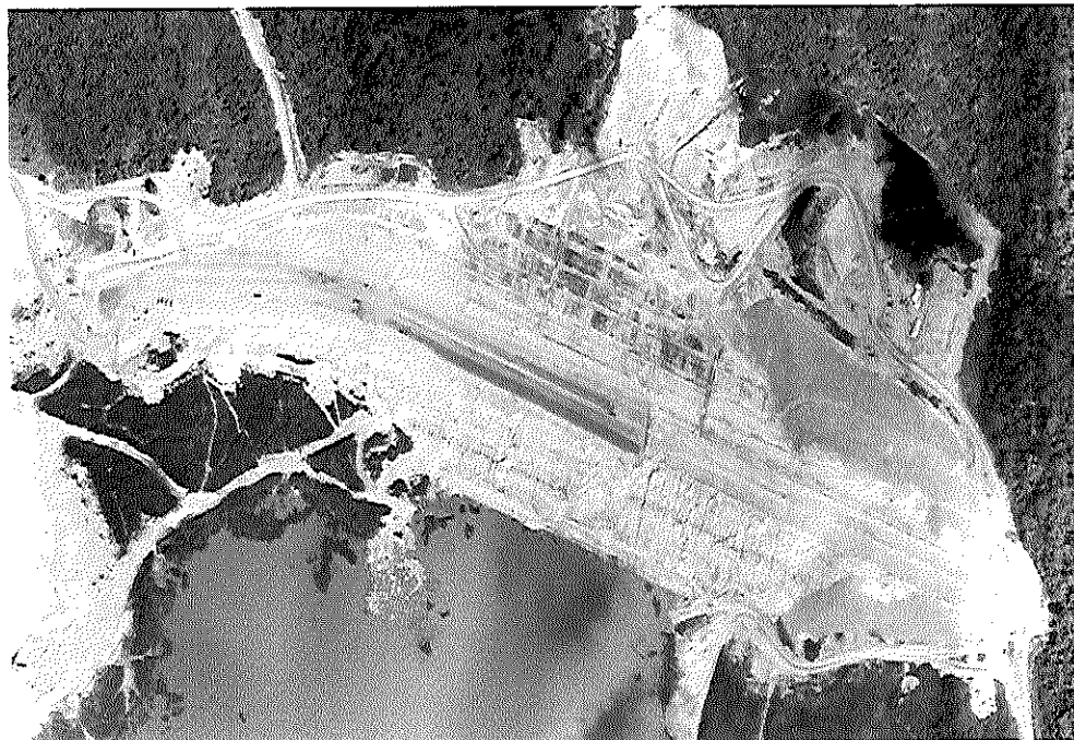
Sítio Belo Monte – Barragem da Vertente do Santo Antônio
