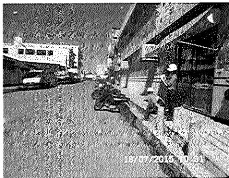
ALTAMIRA TESTE DA REDE DE ÁGUA
