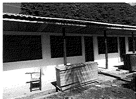
ALTAMIRA REFORMA E ADEQUAÇÃO DO QUARTEL DO 16º BATALHAO DE POLICIA MILITAR
