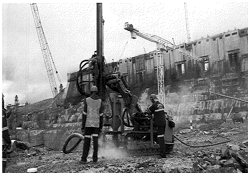
LT 500 kV - Escavação em Rocha do Septo do Canal de Fuga Torre 1-1B
