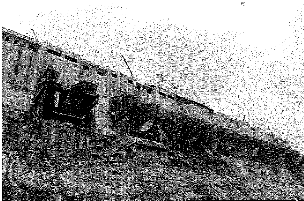
Sítio Belo Monte – Tomada D'água 01 a 08 – Vista jusante
