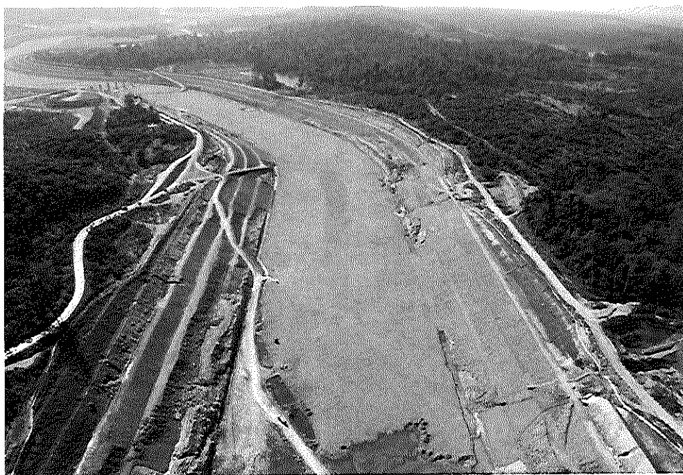
Canal de Derivação – Km 9,0 ao km 13,0 - Vista geral do revestimento dos taludes e fundo do Canal
