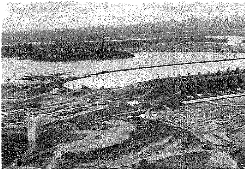
Sítio Pimental – Barragem de Ligação Ilha da Serra – Execução do aterro compactado – ao fundo Muro de Abraço Direito
