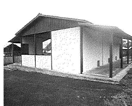
CONSTRUÇÃO CASA DE FARINHA, NA ALDEIA TA-AKATI
