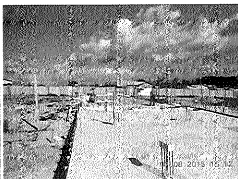
ANAPU CONSTRUÇÃO DE EMEI E EMEF SÃO LUIZ
