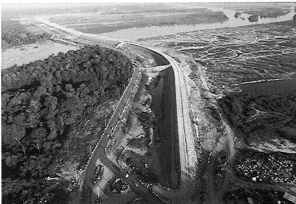
Sítio Pimental – Barragem Lateral Esquerda
