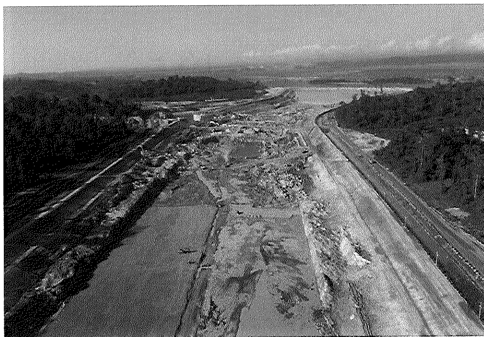
Canal de Derivação – Km 0 ao Km 2,5 - Vista geral das escavações e revestimento de fundo
