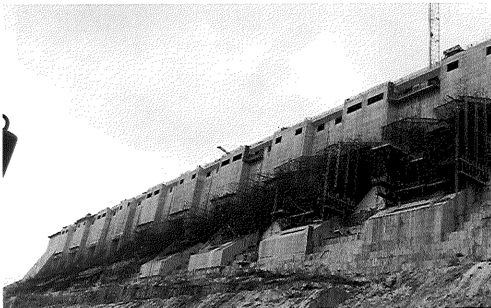
Sítio Belo Monte - Tomada D'água 09 a 18 – Vista jusante
