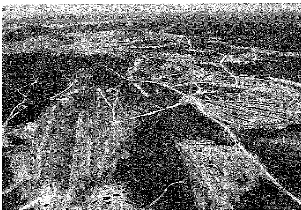
Reservatório Intermediário - Dique 7B
