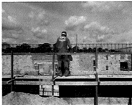
CONSTRUÇÃO DE UNIDADE BÁSICA DE SAÚDE INDÍGENA TIPO 01 ALDEIA FURO SECO
