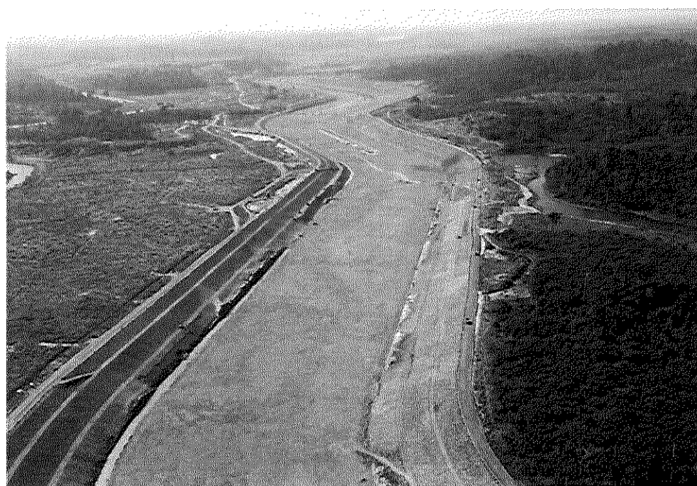
Canal de Derivação – Km 16,5 ao km 18,0 - Vista geral do revestimento dos taludes e fundo do Canal
