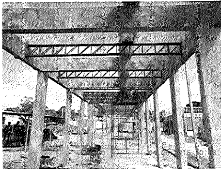
VITÓRIA DO XINGU CONSTRUÇÃO DE HOSPITAL MUNICIPAL
