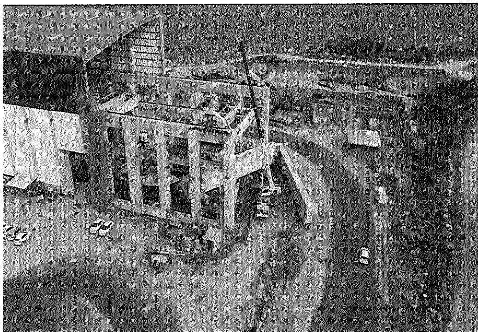
Sítio Belo Monte - Montagem da Ponte Rolante Auxiliar nº 1
