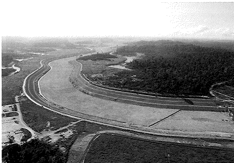
Canal de Derivação – Km 13,5 ao km 16 - Vista geral do revestimento dos taludes e fundo do Canal
