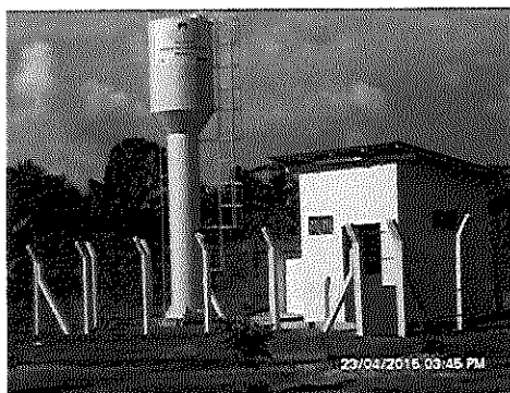
SISTEMA DE ABASTECIMENTO DE AGUA NA ALDEIA RAI DE SOL
