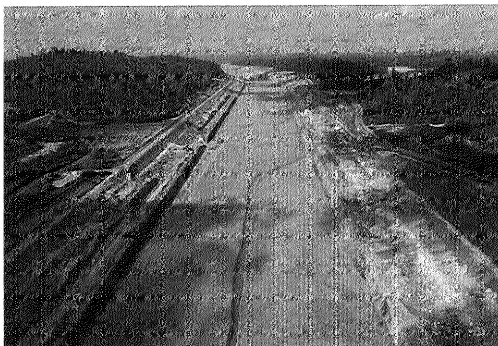
Canal de Derivação – Km 3,5 ao Km 6,0 - Vista geral do revestimento de fundo e lateral
