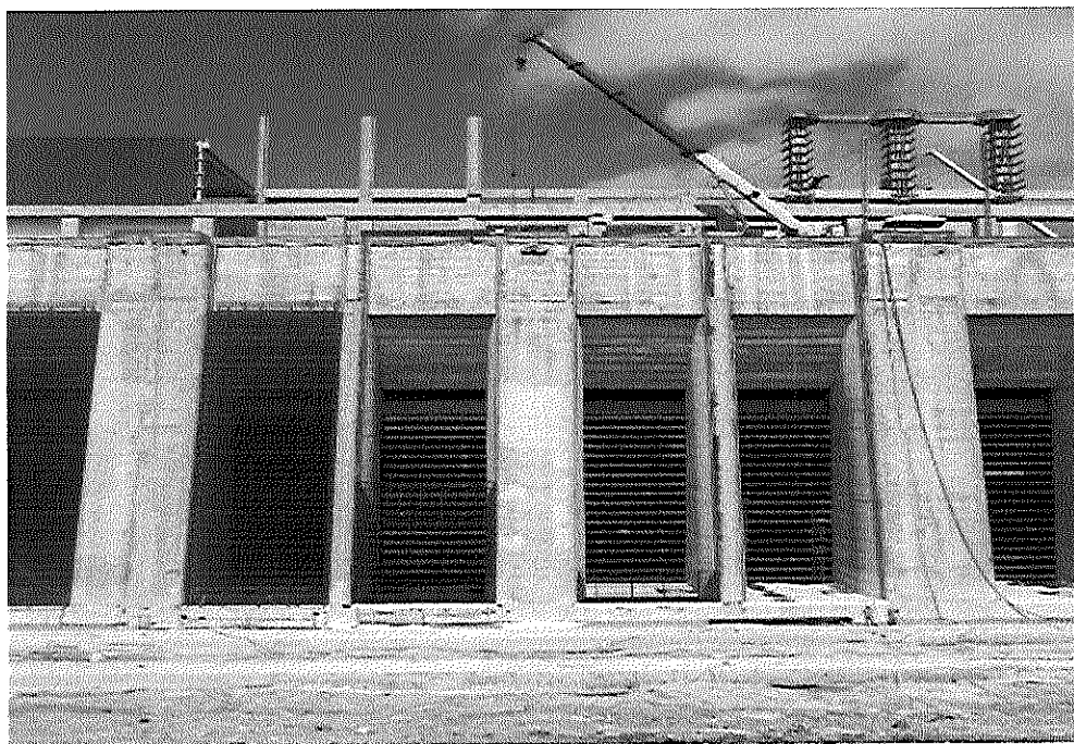
Sítio Pimental – Tomada d'água – Vista à montante TA-02
