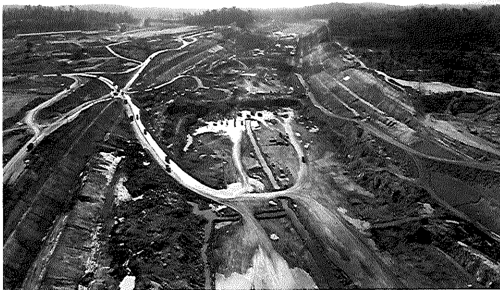
Canal de Derivação – Km 6,5 ao km 9,0 - Vista geral da escavação em rocha
