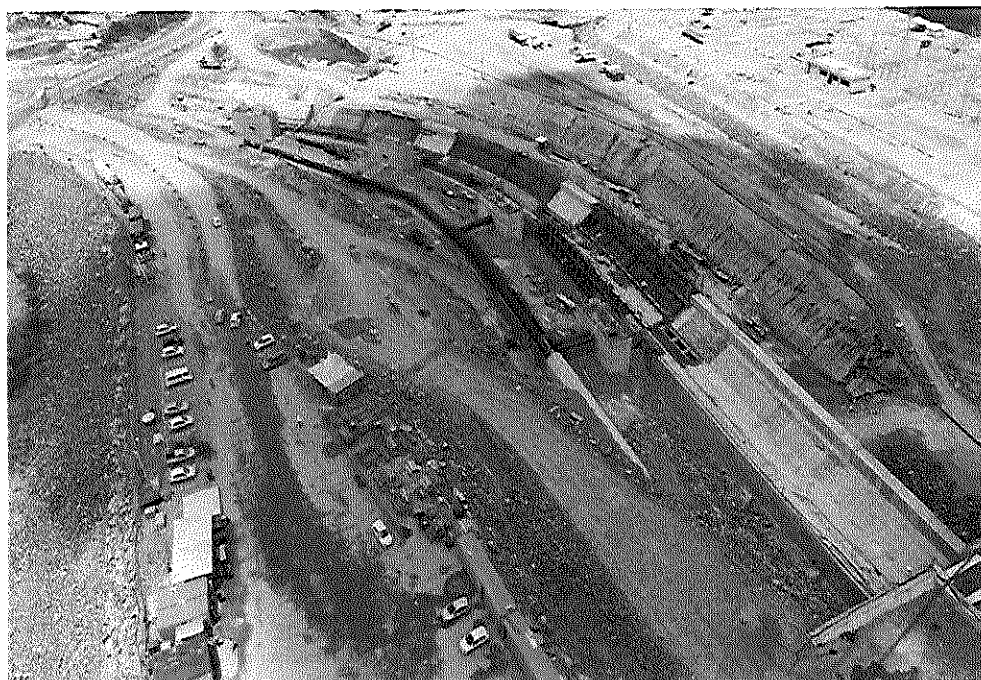
Sítio Pimental – Sistema de Transposição de Peixes – Armação e concretagem do canal
