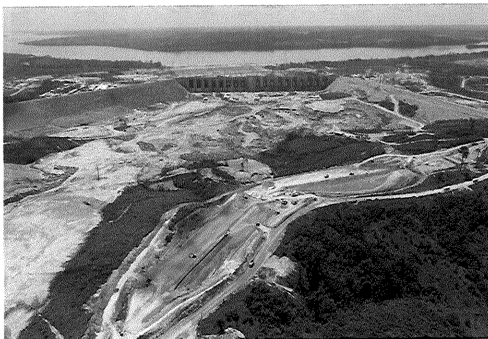
Reservatório Intermediário - Dique 6A
