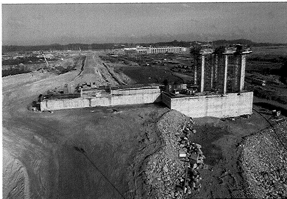
Sítio Pimental – Sistema de Transposição de Peixes –Estrutura de Saída
