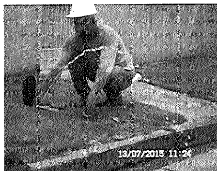
ALTAMIRA TESTE DA REDE DE ÁGUA
