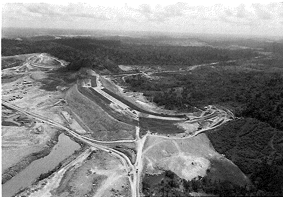
Reservatório Intermediário - Dique 8A
