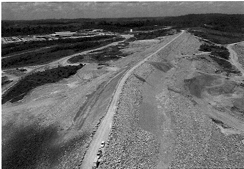
Sítio Belo Monte – Barragem de Fechamento Direita
