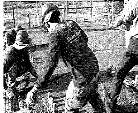
CONSTRUÇÃO DE UNIDADE BÁSICA DE SAÚDE INDÍGENA TIPO 01 NA ALDEIA BOA VISTA
