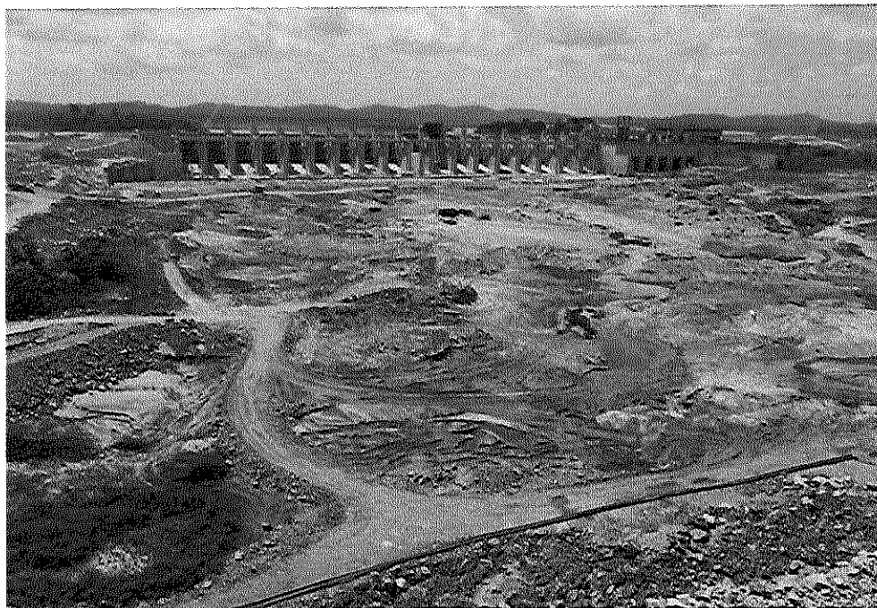
Sítio Pimental – Vertedouro – Vista de Jusante
