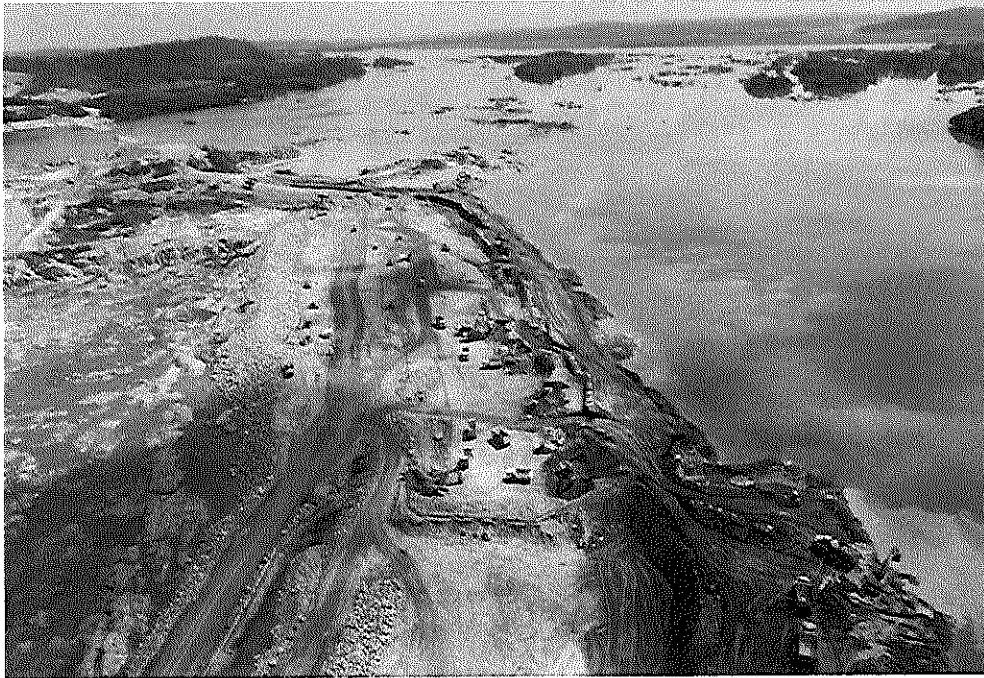
Sítio Pimental – Canal Central – Rebaixamento da Ensecadeira de Montante
