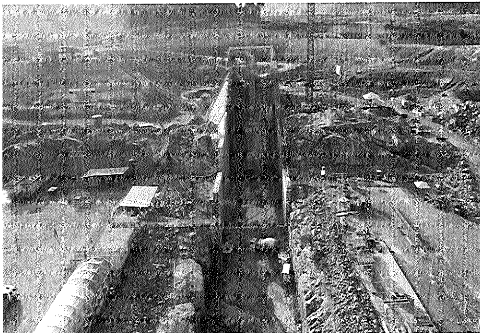
Canal de Derivação – Vertedouro de Enchimento
