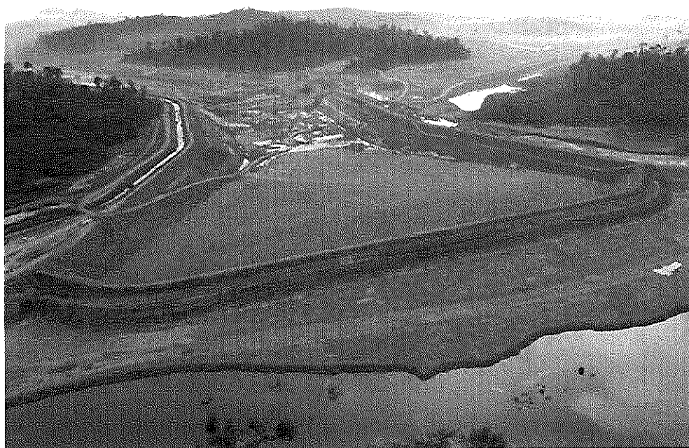
Canal de Derivação – Emboque - Vista geral das escavações e revestimento de fundo
