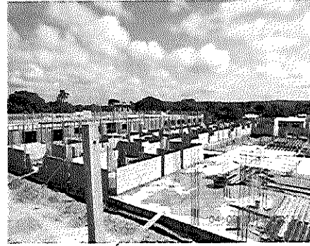
VITÓRIA DO XINGU CONSTRUÇÃO DE HOSPITAL MUNICIPAL
