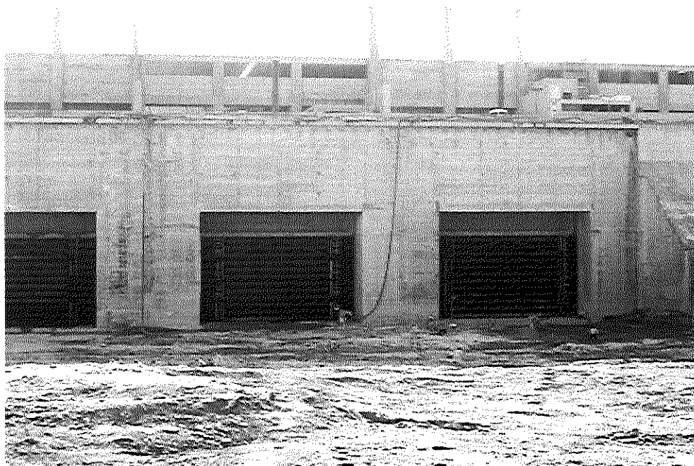
Sítio Pimental – Casa de Força – Vista à Jusante – Sucção – Bloco 1
