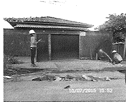
ALTAMIRA TESTE DA REDE DE ÁGUA
