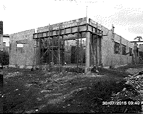
ALTAMIRA CONSTRUÇÃO DO CRAS NO RUC SÃO JATOBÁ
