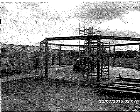
ALTAMIRA CONSTRUÇÃO DO CREAX NO RUC SÃO JOAQUIM
