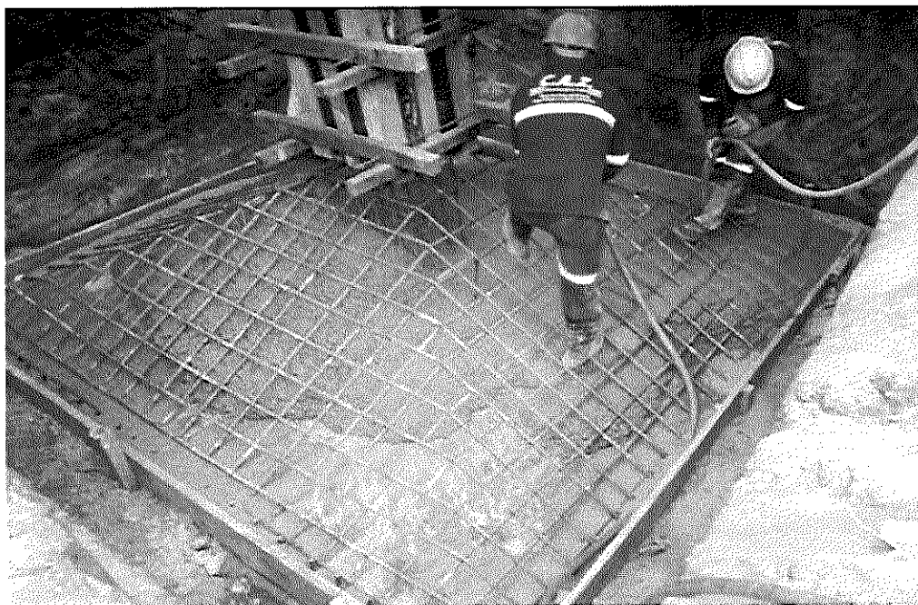
LT 500 kV - Concretagem de Fundação Torre 4-3B
