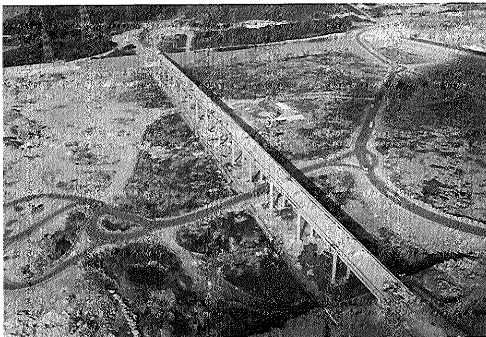
Sítio Belo Monte – Ponte sobre o Canal de Fuga - Desvio da Transamazônica - BR-230
