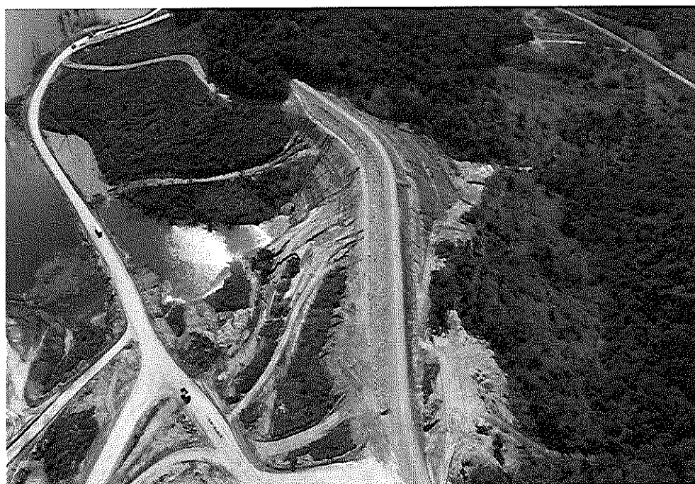
Reservatório Intermediário - Dique 14D
