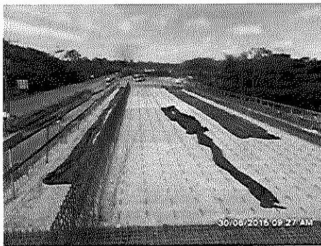
ALTAMIRA PONTE SOBRE IGARAPÉ PANELAS - AV. TRANCREDO NEVES
