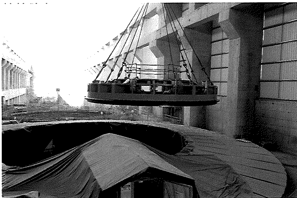
Sítio Belo Monte - UG01 – Tampa superior da turbina em lançamento
