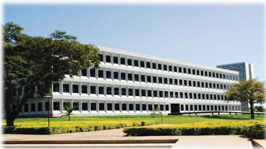
Edifício Sede do TCU em Brasília - DF
