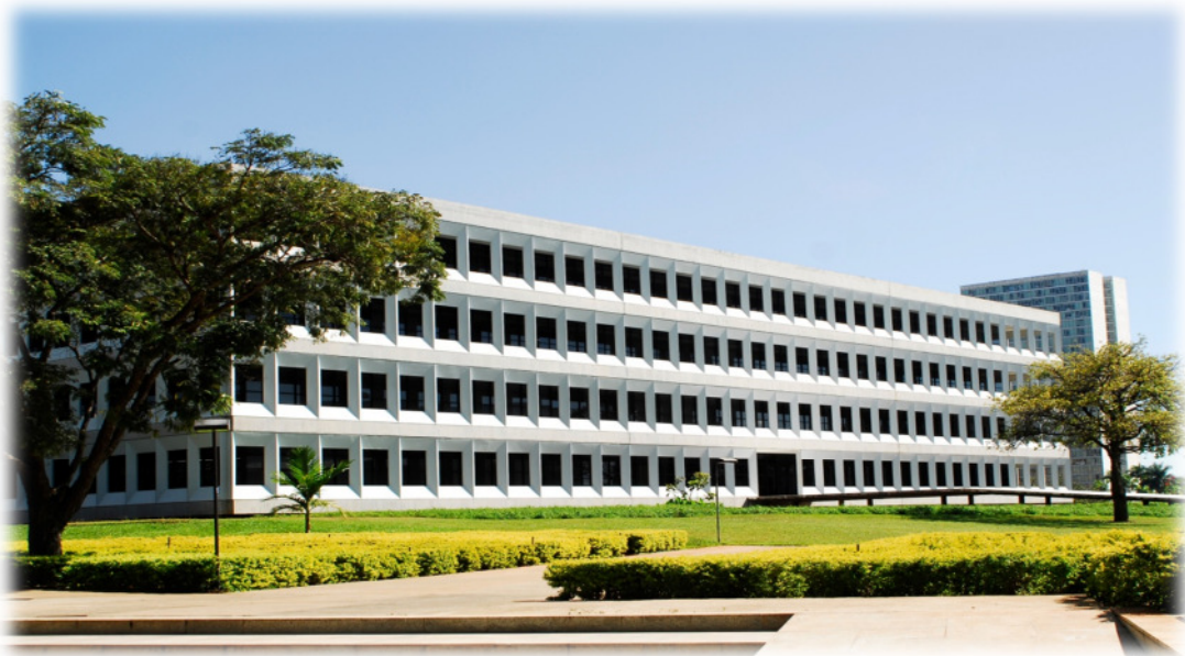
Edifício Sede do TCU em Brasília - DF
