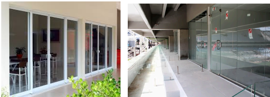
Figuras 6 e 7 – À esquerda, caixilho de vidro fixo nas laterais da porta de correr. À direita, vidro fixo em perfis de alumínio e silicone entre as chapas, do camarote da Arena Pantanal ( www.arenapantanalobras.com.br )
