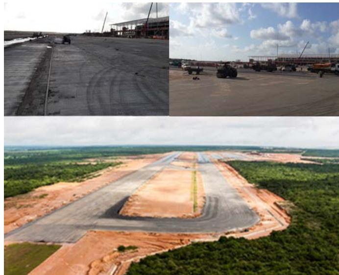
**Descrição:** Execução dos Serviços de Terraplanagem das Pistas de Taxamento e do Pátio de Aeronaves, Execução de Canaletas do Sistema de Drenagem do Lado Ar, CBUQ (Binder) das Pistas de Taxamento, CBUQ (Capa) da Pista de Pouso e Infraestrutura de Balizamento nas Bordas Internas das Pistas
