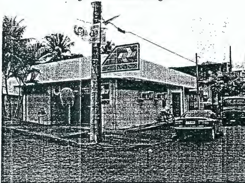
Figura 1: vista externa da agência
