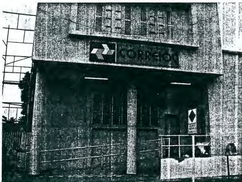
Figura 1. Tomada externa da fachada da agência dos Correios em Goiana.
