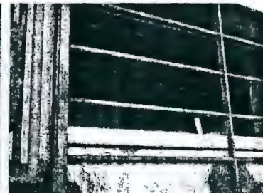
Fotos 15 a 17 - Marcas produzidas pelo arrancamento da grade na janela danificada e por tentativa de arrancamento na janela vizinha.
