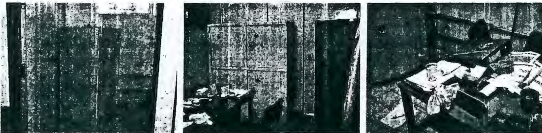
Fotos 27 a 29 - Detalhes da sala onde se encontrava o cofre da Agência.
