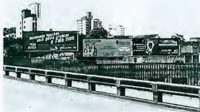
Viaduto Francisco Sales sentido Floresta (Próximo ao Extra Supermercado)
