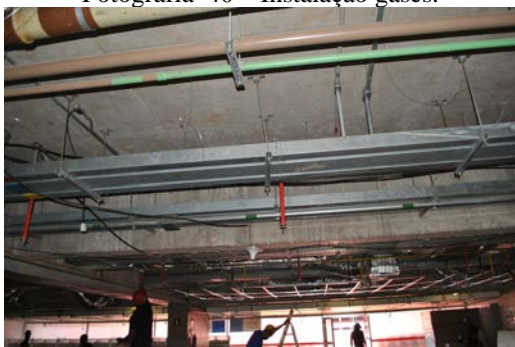
Fotografia 41 – Eletrocalhas para cabos.
