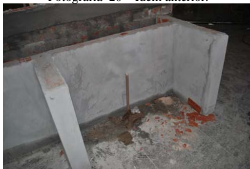
Fotografia 21 – Apoio para as bancadas de inox.
