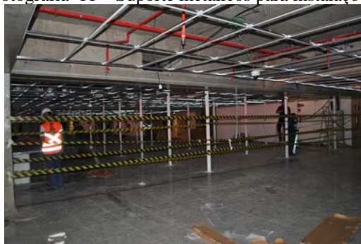
Fotografia 12 – Suportes dos forros.
