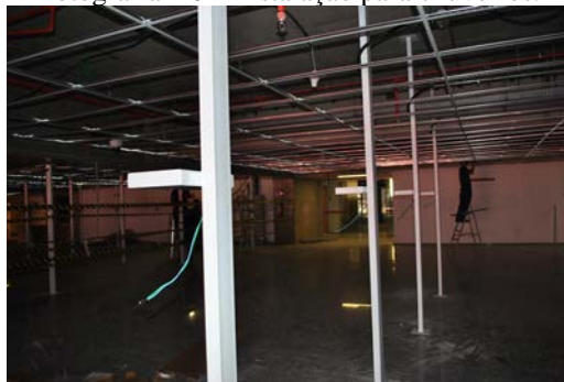
Fotografia 11 – Suporte metálicos para instalações.
