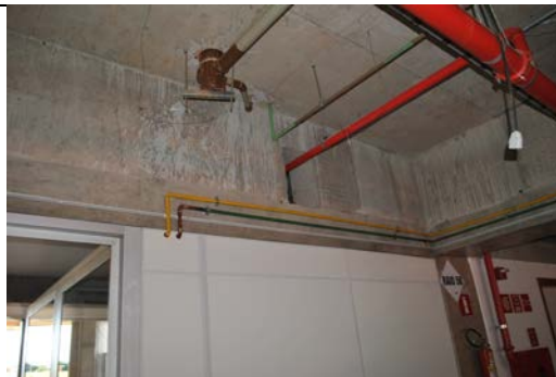
Fotografia 42 – Pontos para gases.
