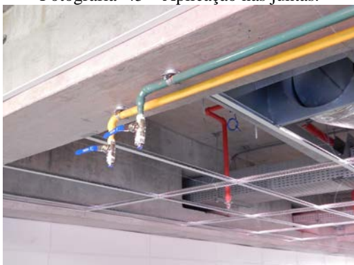
Fotografia 46 – Detalhe dos pontos de gases.
