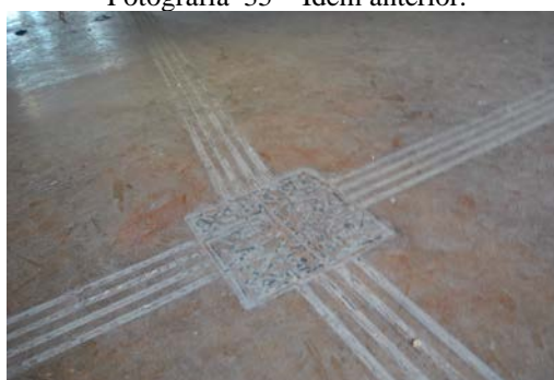
Fotografia 36 – Detalhe da remoção do piso podotátil.
