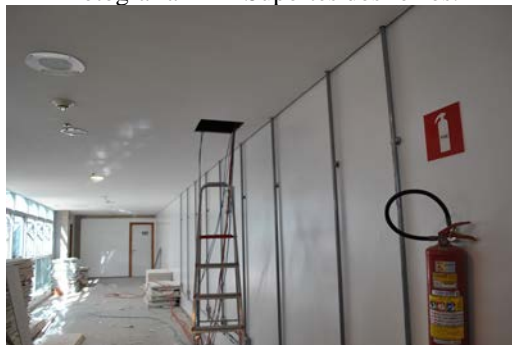
Fotografia 13 – Eletrodutos metálicos para instalação.
