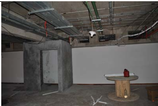
Fotografia 7 – Eletrocalhas para instalações elétricas.
