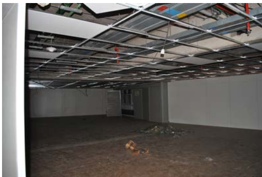
Fotografia 3 – Suportes do forro em placas.
