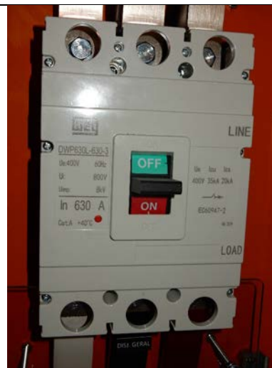
Fotografia 48 – Detalhe do disjuntor.
