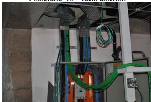
Fotografia 19 – Detalhe das eletrocalhas.
