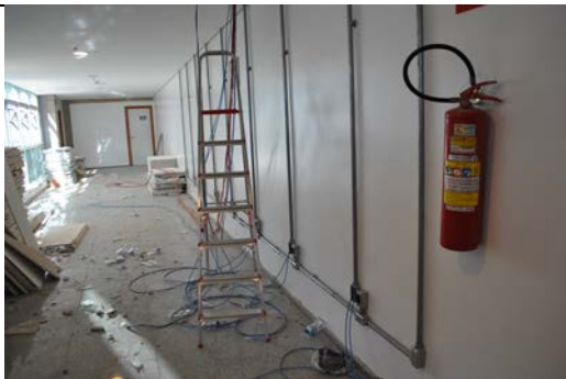
Fotografia 14 – Tomadas elétricas e pontos lógicos.
