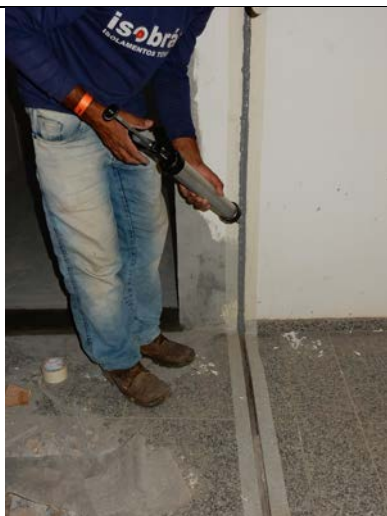
Fotografia 45 – Aplicação nas juntas.
