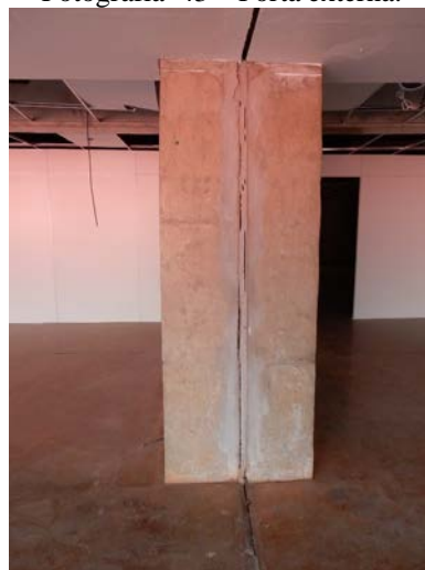
Fotografia 44 – Junta de dilatação.
