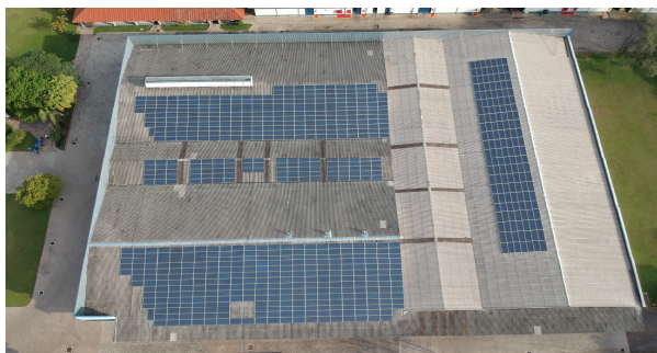
Edifício industrial alimentício, Venâncio Aires (RS).
