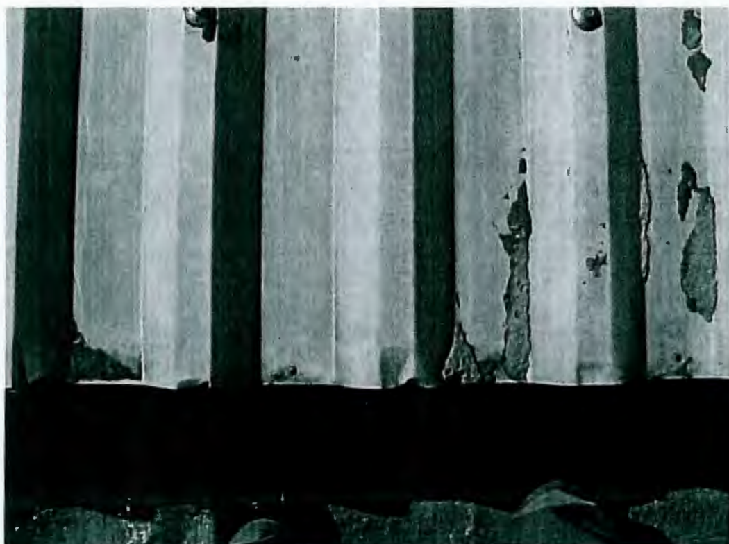
SUBSTITUIÇÃO DE TELHAS SANDUICHE DANIFICADAS PELA PARALIZAÇÃO DOS SERVIÇOS INACABADOS
