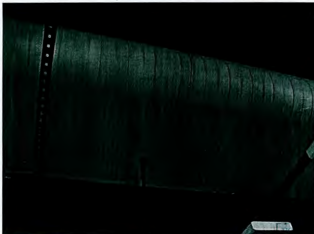
RECUPERAÇÃO DUTOS DE AR CONDICIONADO. DUTOS ENFERRUJADOS PELA INFILTRAÇÃO DE AGUA CAUZADO PELA PARALISAÇÃO PROLONGADA DA OBRA
