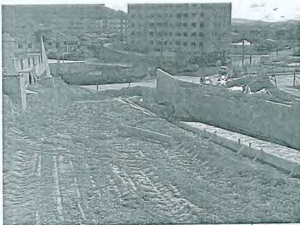
Muro de Arrimo
