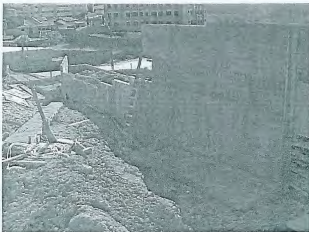
Muros de Arrimo-
