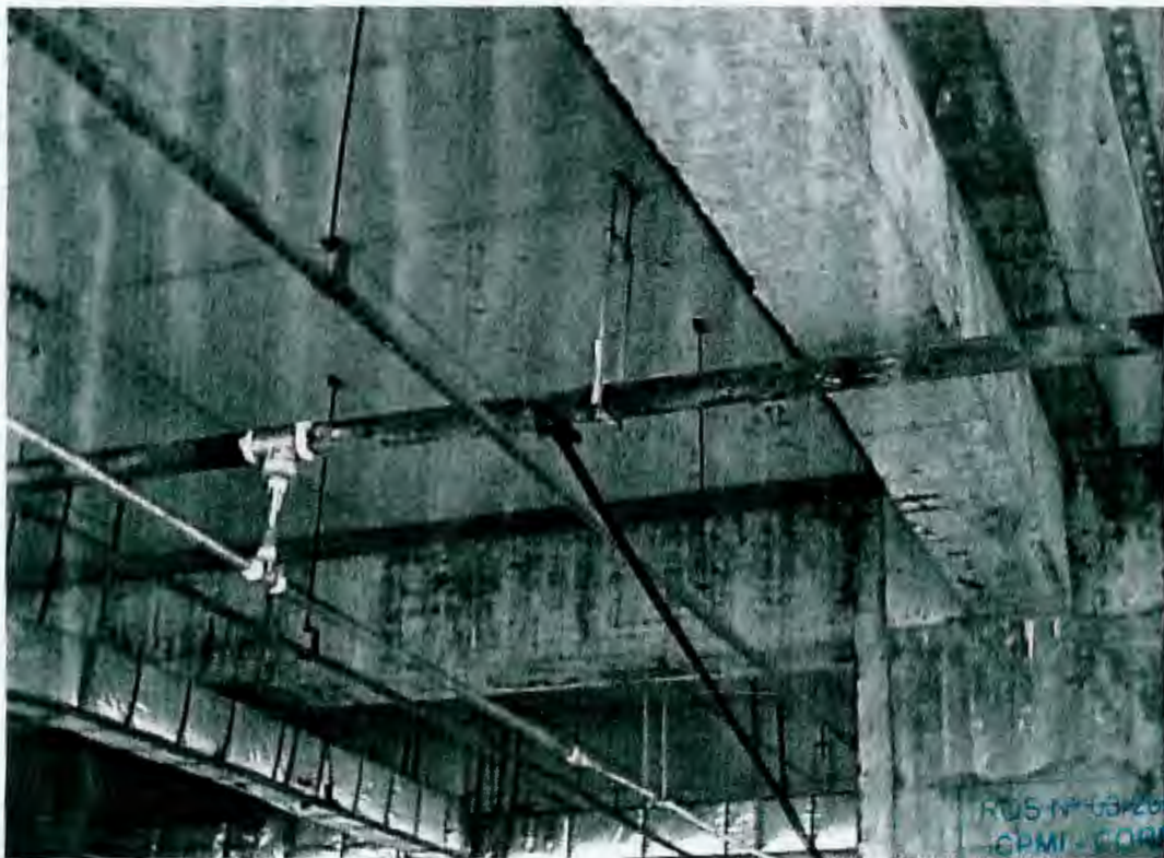
RECUPERAÇÃO DA REDE SPRINKLES. TUBULAÇÃO DANIFICADA PELA INFILTRAÇÃO DE AGUA CAUZADO PELA PARALIZAÇÃO PROLONGADA DA OBRA
