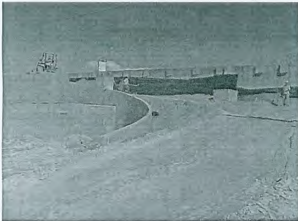
Muro de Arrimo
