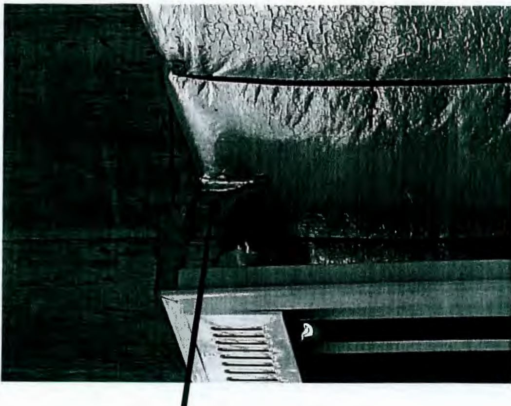
RECUPERAÇÃO DUTOS DE AR CONDICIONADO. DUTOS ENFERRUJADOS PELA INFILTRAÇÃO DE AGUA CAUZADO PELA PARALISAÇÃO PROLONGADA DA OBRA
