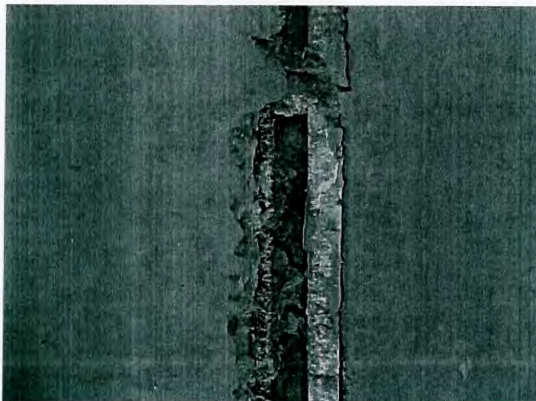
TRATAMENTO DA JUNTA DE DILATAÇÃO INCLUSIVE FERRAGENS DANIFICADOS COM O TEMPO DE PARALIZAÇÃO DA OBRA
