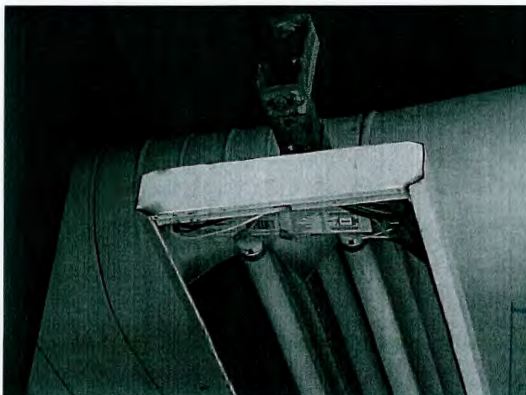
RECUPERAÇÃO DAS LUMINÁRIAS. LUMINÁRIAS DANIFICADAS PELO ABANDONO DA OBRA. LUMINÁRIAS SOLTAS, LUMINÁRIAS ENFERRUJADAS PELA AÇÃO DO TEMPO
