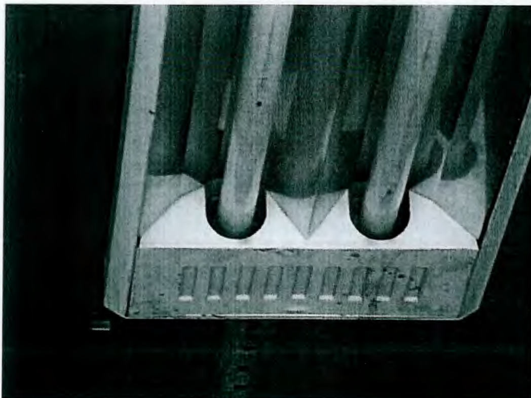
RECUPERAÇÃO DAS LUMINÁRIAS. LUMINÁRIAS DANIFICADAS PELO ABANDONO DA OBRA. LUMINÁRIAS SOLTAS, LUMINÁRIAS ENFERRUJADAS PELA AÇÃO DO TEMPO
