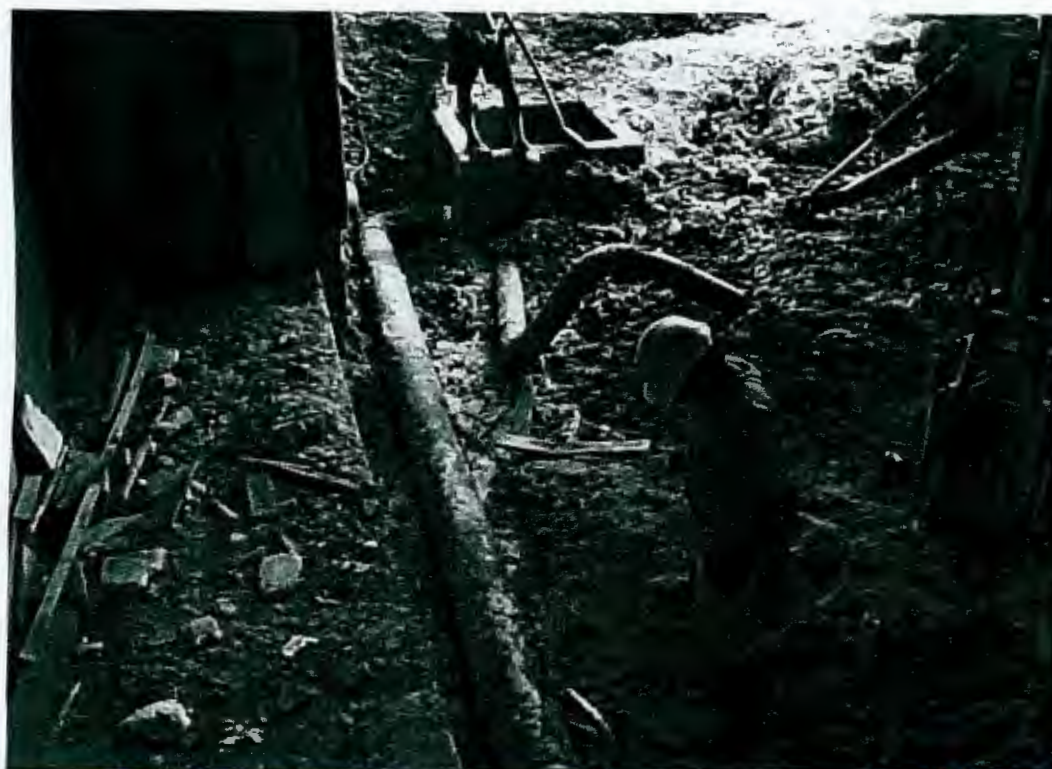
RECUPERAÇÃO/ SUBSTITUIÇÃO DRENAGEM DANIFICADOS PELO TEMPO DE OBRA PARALIZADA
