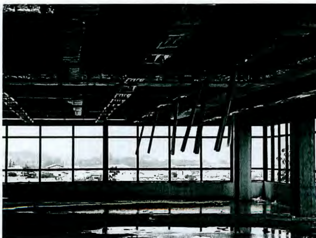
RECUPERAÇÃO DAS LUMINÁRIAS. LUMINÁRIAS DANIFICADAS PELO ABANDONO DA OBRA. LUMINÁRIAS SOLTAS, LUMINÁRIAS CAIDAS PELA FORÇA DO VENTO
