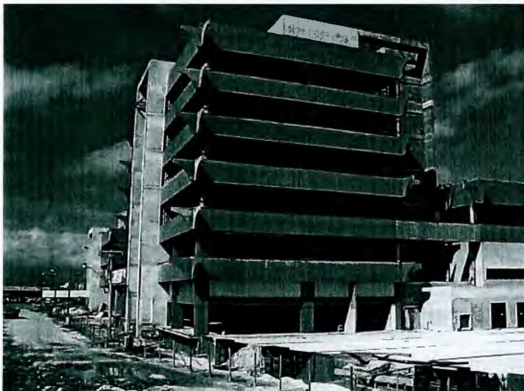
RECUPERAÇÃO DE PINTURA. PINTURA REFEITA, DANIFICADA PELO TEMPO DE PARALIZAÇÃO DA OBRA
