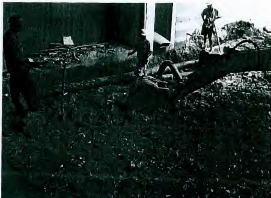
RECUPERAÇÃO/ SUBSTITUIÇÃO DRENAGEM DANIFICADOS PELO TEMPO DE OBRA PARALIZADA
