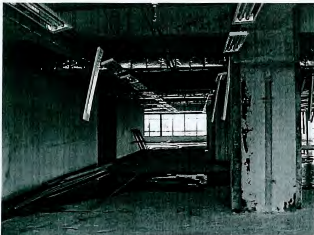
RECUPERAÇÃO DAS LUMINÁRIAS. LUMINÁRIAS DANIFICADAS PELO ABANDONO DA OBRA. LUMINÁRIAS SOLTAS, LUMINÁRIAS CAIDAS PELA FORÇA DO VENTO
