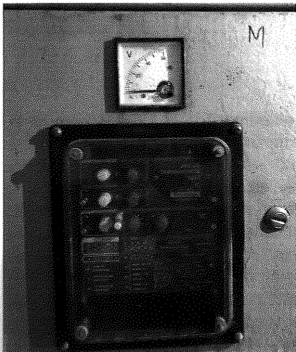
Relés de Proteção Geral de Entrada Inoperantes (sem tensão auxiliar e sem fiação dos TC's)
