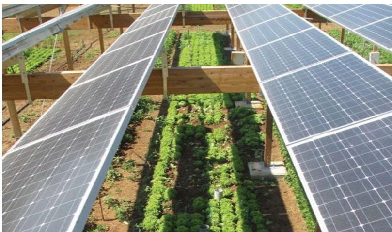
Sistema Agrofotovoltaico piloto de 50 kWp da Universidade de Montpellier, França, 2018. Cultivo de alface e outras hortaliças.
