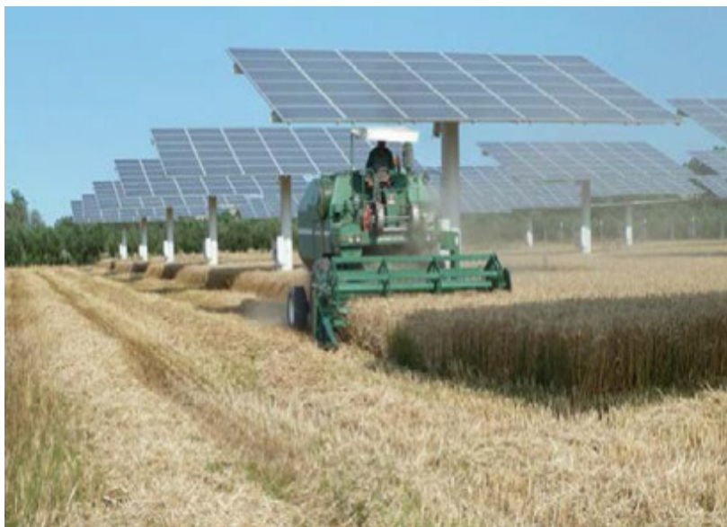
Sistema Agrofotovoltaico de 800 kWp em Campo d'Eco, Itália, 2014. Cultivo de tomate, melancia, frutas da estação e trigo.
