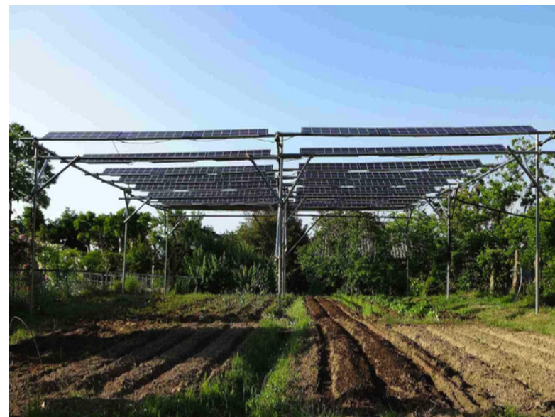
Sistema Agrofotovoltaico de 50 kWp em Tsukuba, Japão, 2013. Cultivo de berinjela, amendoim, tomate, repolho, pepino, inhame e frutas cítricas.
