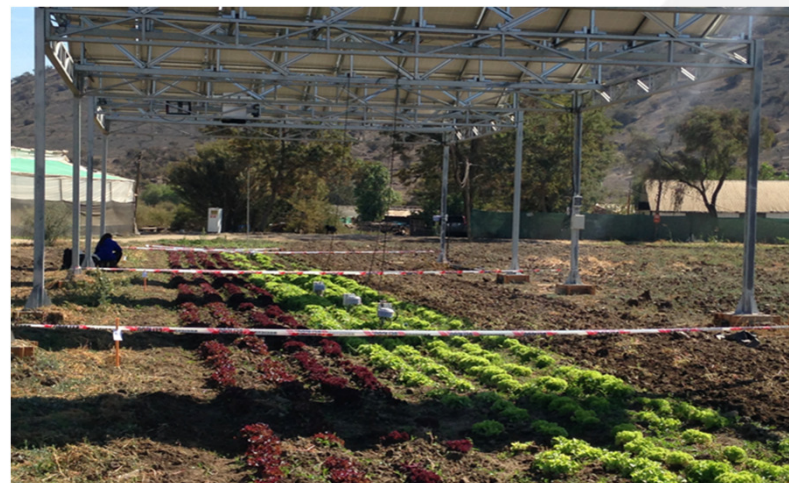
Sistema Agrofotovoltaico piloto de 13 kWp do Instituto Fraunhofer ISE, Chile, 2019. Cultivo de alface.
