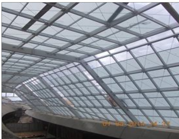
Cobertura – ampliação saguão
