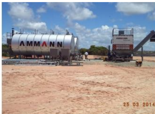
Instalação da Usina de Asfalto
