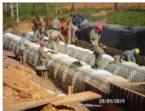
Execução do bueiro tubular
