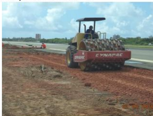
Sub-base Estabilizada (Cab.11)
