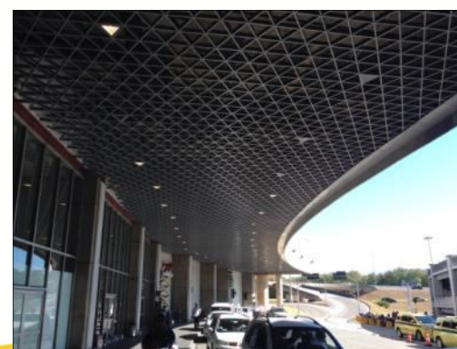
Meio fio com forro da calçada
