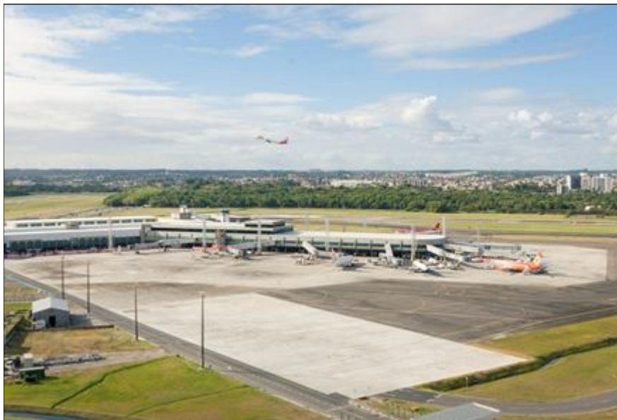
Ampliação Pátio de aeronaves
