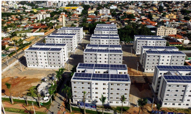
Sistema em condomínio residencial , Belo Horizonte (MG).
