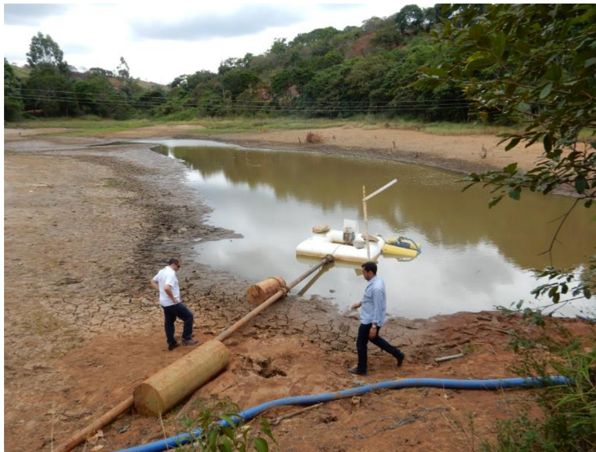
Ex: Restabelecimento emergencial de Captações de água
