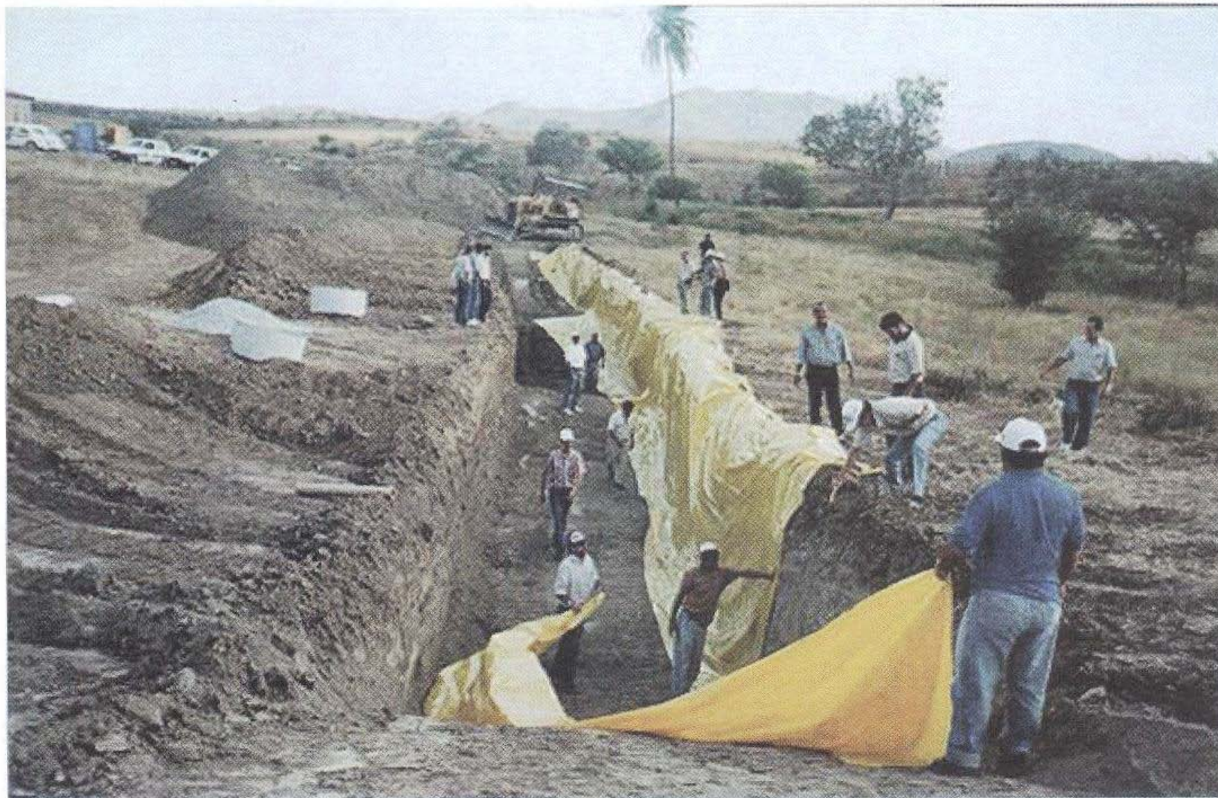
Figura 8 Construção de barragem subterrânea – escavação e colocação de manta impermeável.
