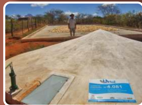
Cisterna Enxurrada (52 mil litros)
