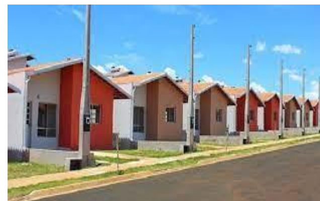
Infraestrutura de rede elétrica interna
