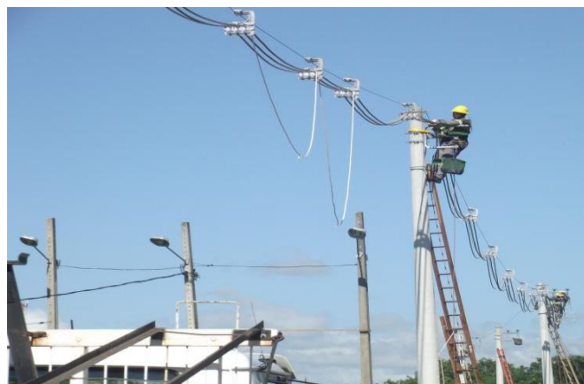
Obra de Conexão Infraestrutura externa
