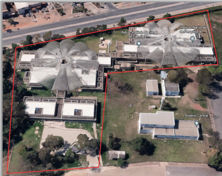
Vista aérea do INPP com delimitação dos blocos.
