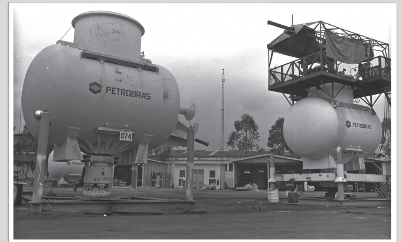
Câmara submarina wellhead cellar do poço da plataforma fixa de Garoupa na Bacia de Campos.
