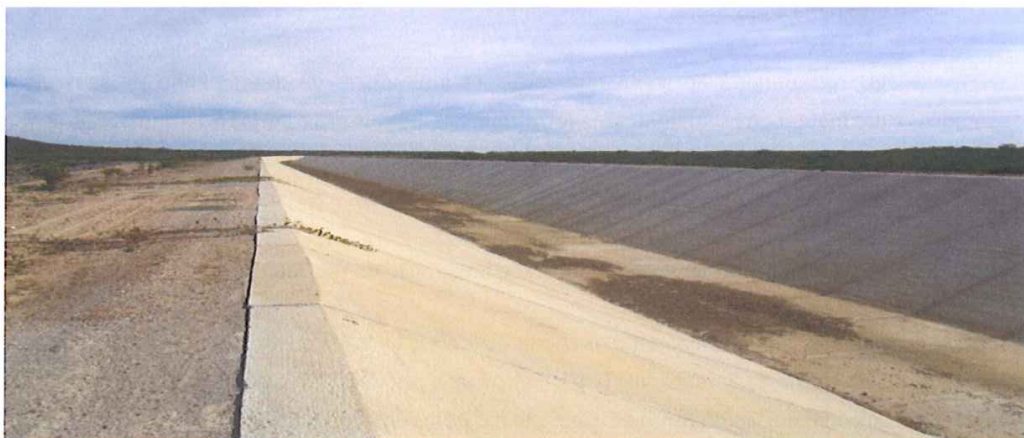
RIO SÃO FRANCISCO – Obra de Integração – Eixo Norte – Lote 5
