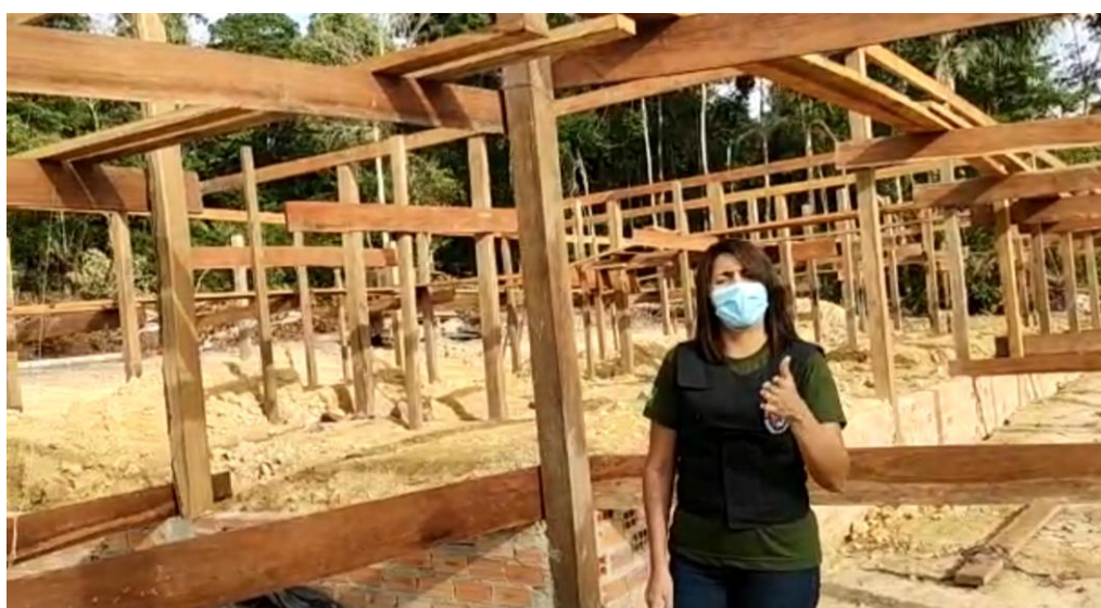
Figura 5 - Construção da nova estrutura da "BAPE Norte", FPE Awá - MA.
