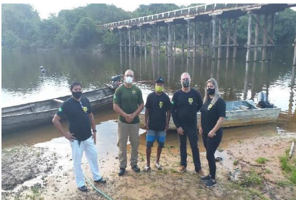
Figura 23 - Barreiras sanitárias de controle fluvial implementadas por servidores da Funai.
