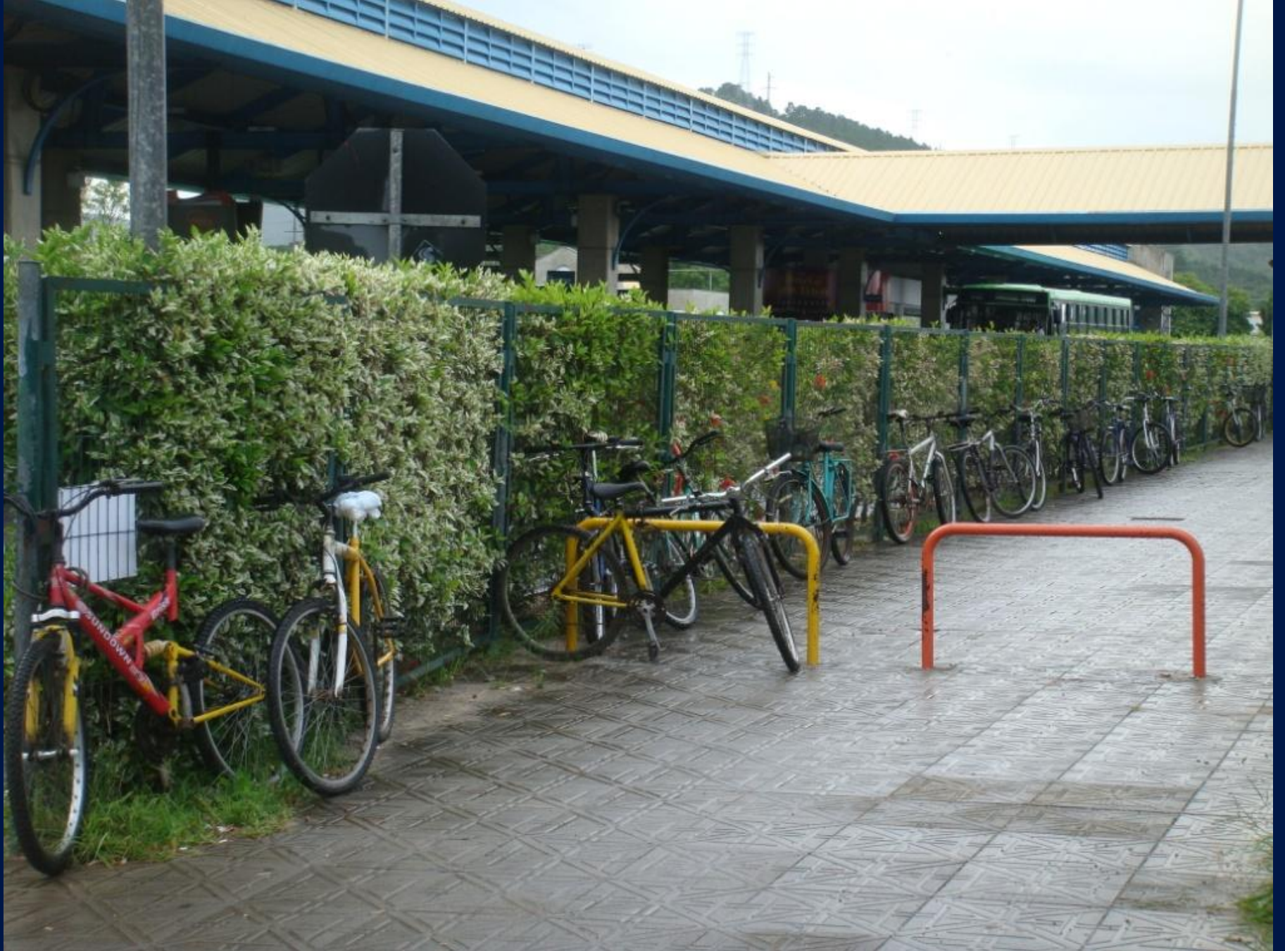
Terminal de ônibus – Florianópolis (SC)
