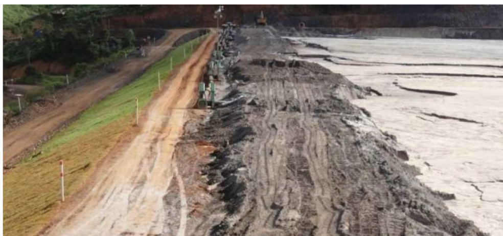
Figura 8 – Primeiro alteamento da barragem do Fundão 17 .
