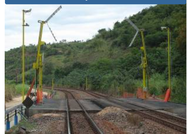
Sistema de Aspersor de Minério
