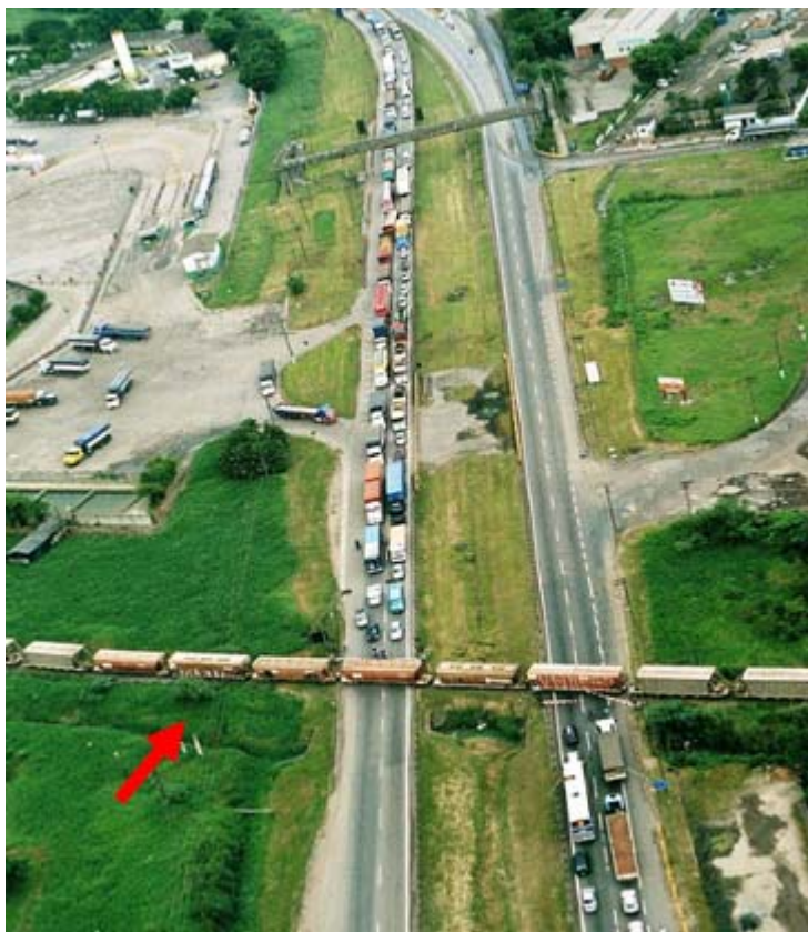
Implantação de Viaduto na Rodovia SP 55
