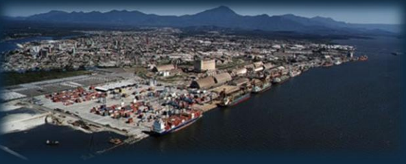
Porto de Paranaguá (PR)
