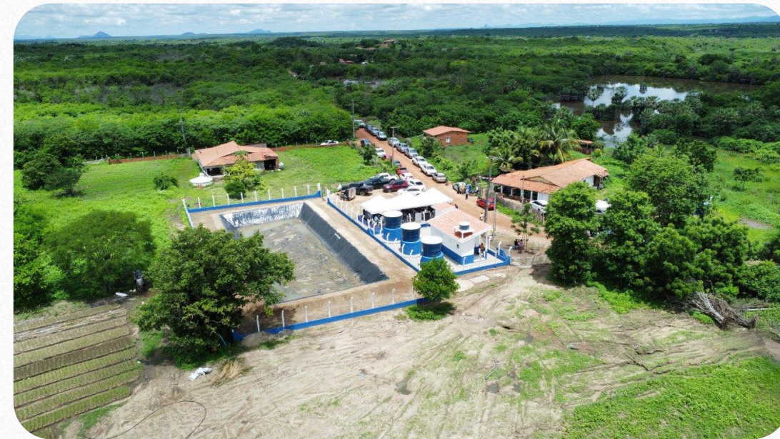
Milésimo sistema de dessalinização instalado no município de Chorozinho/Ceará em abril/2024
