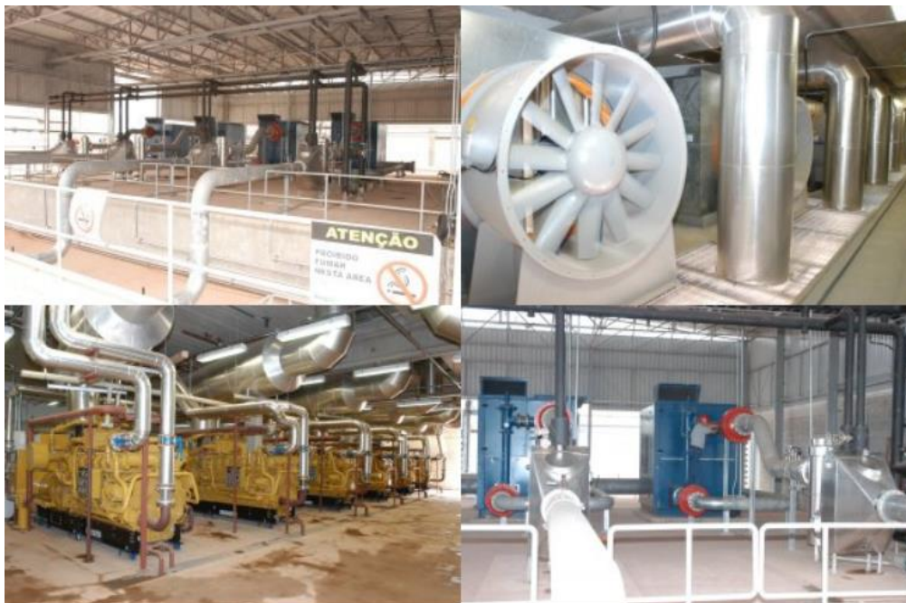
Figura 34 Instalações da unidade de geração elétrica com biogás do Aterro Sanitário Bandeirantes, em São Paulo
