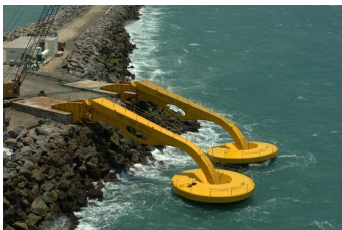
Figura 13 Usina de ondas do PECÉM
