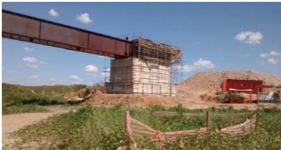
Ponte 13 - EST 84+500 - Desforma Paredes e Lajes do Encontro E01
