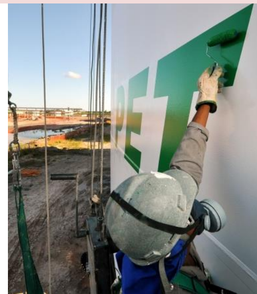
Atividades de Pintura
