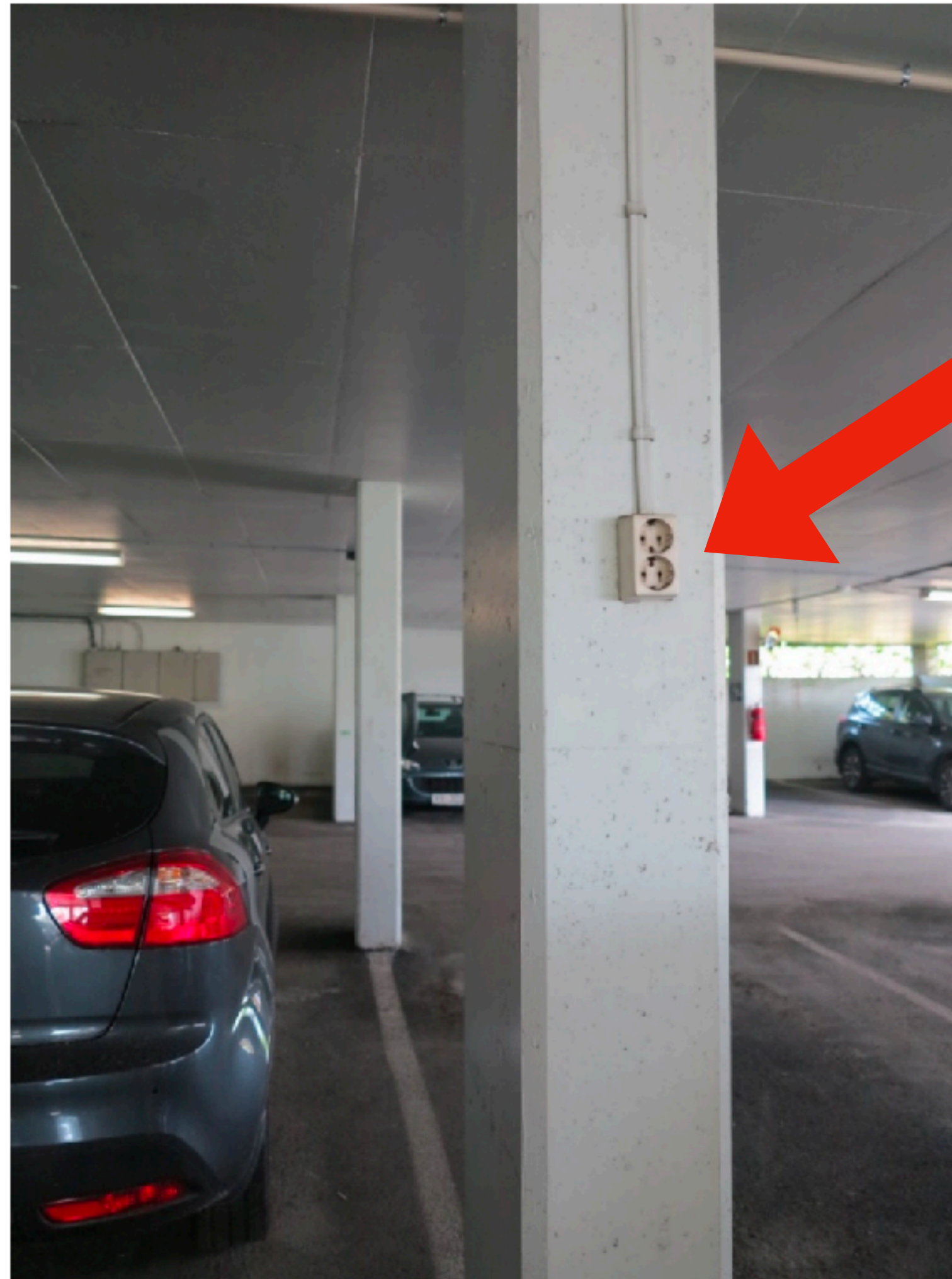
Figur 3-4 Før installasjon av ladebokser ble stikkontakter beregnet for motorvarmere brukt til lading av elbiler. Etter installasjonen av ladesystemet har det blitt innført forbud mot å lade bil via stikkontakt.
