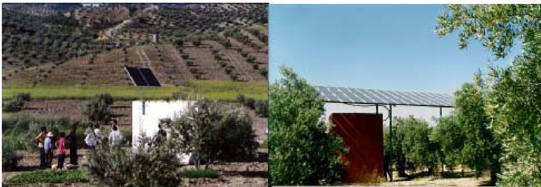
Sistemas fotovoltaicos de bombeamento utilizados para irrigação de oliveiras em Jaén, Espanha
