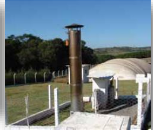
• Uso de biodigestores
