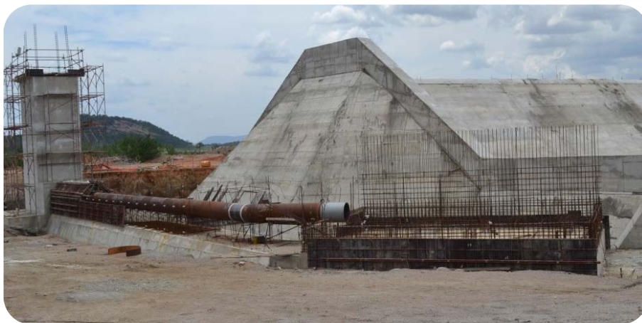
Tomada de uso difuso do Res. Serra do Livramento - Montagem da tubulação da adutora.
