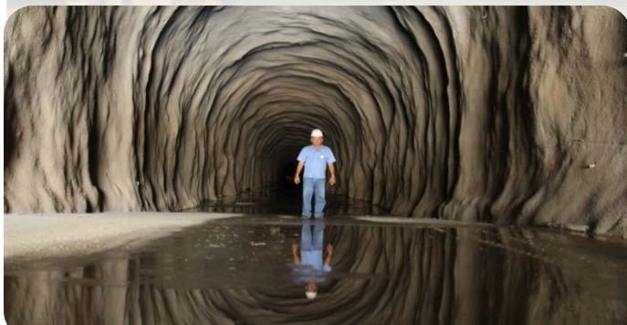
Túnel Cuncas II – Piso executado.
