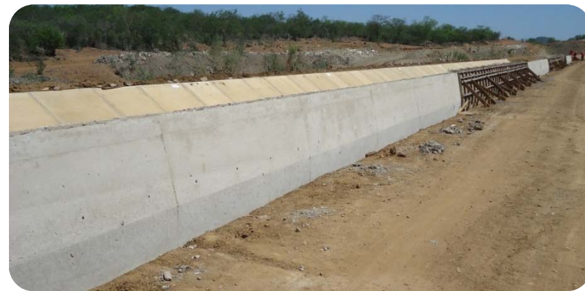
WBS-2212- Segmento de canal - Execução de muretas no segmento de canal
