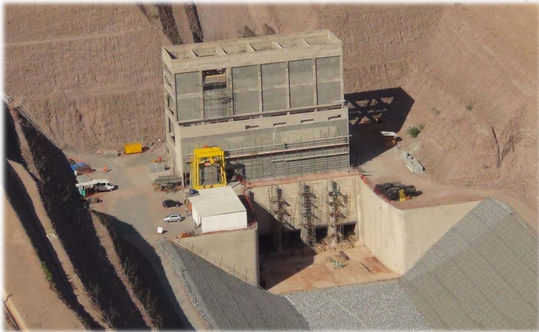
EBV-01 – Execução da alvenaria, montagem da ponte rolante e da tubulação da (peça em Y) na estação de bombeamento.
