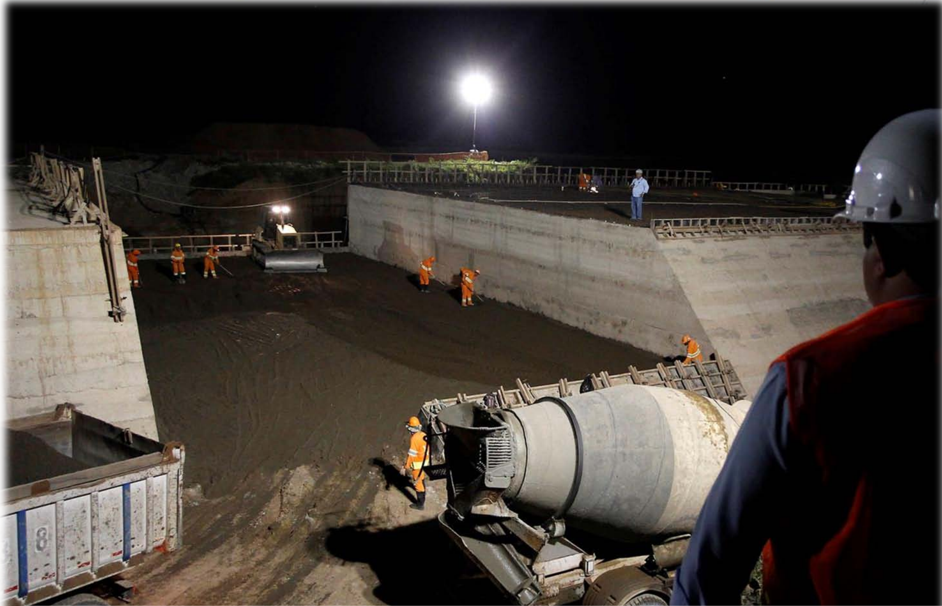
Reservatório Porcos - Execução de CCR no vertedouro.
