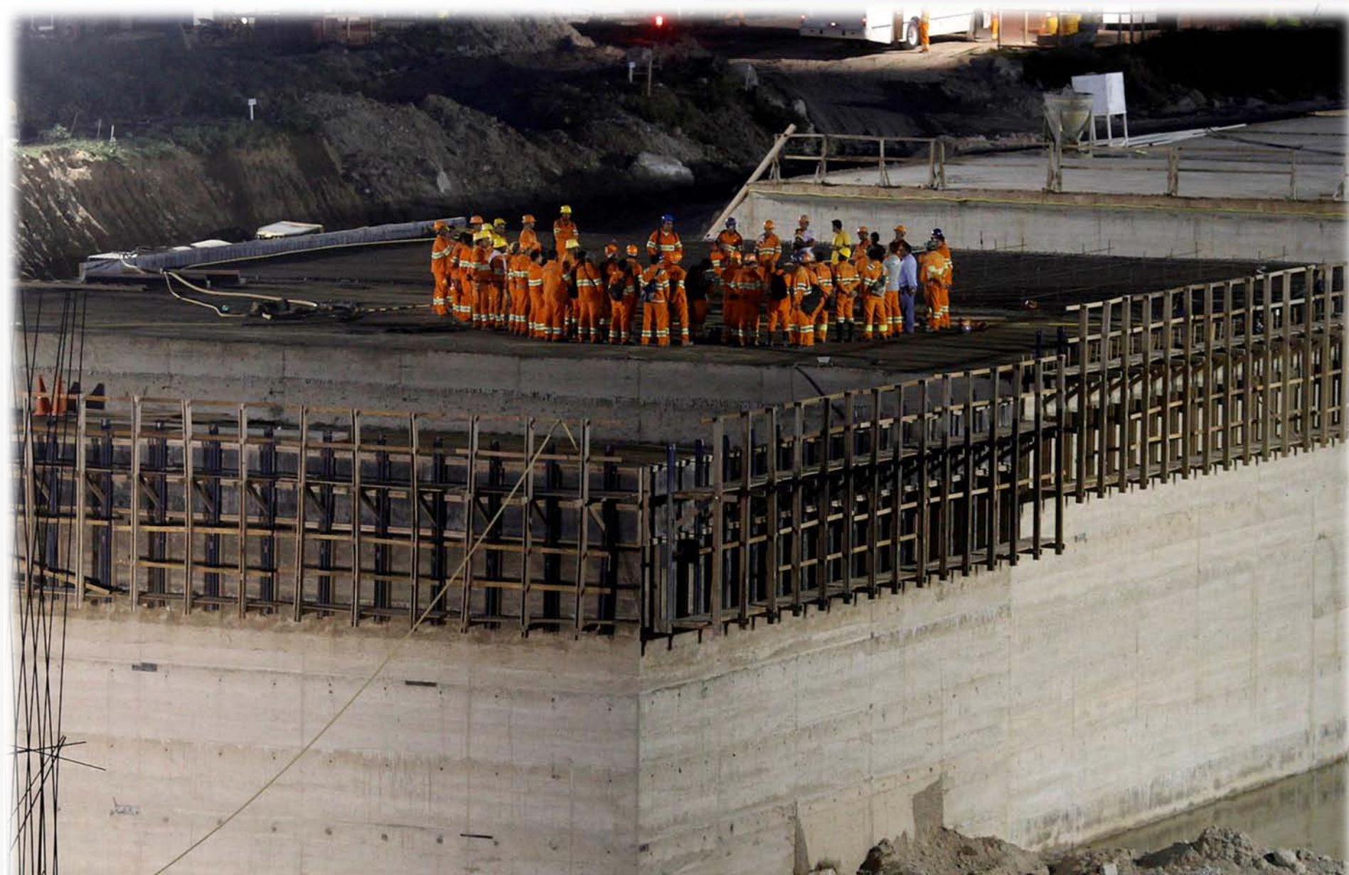
Reservatório Porcos - Execução de CCR no vertedouro.
