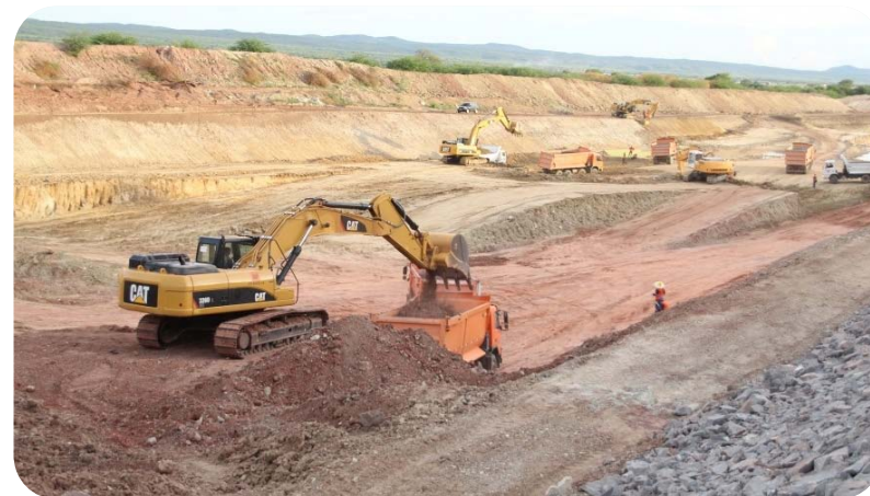
WBS 1234 - Escavação de canal anterior ao Túnel Cuncas I.
