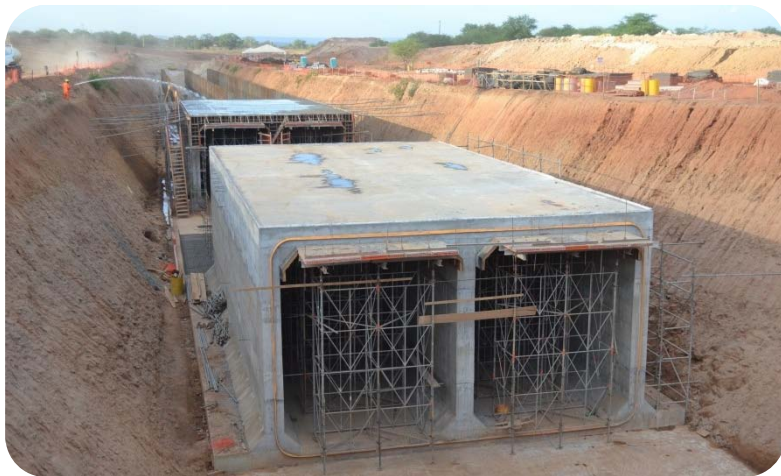
WBS 1365 - Galeria Milagres - Células concretadas e execução da cura do concreto
