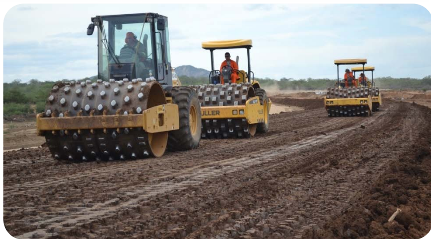
Reservatório Terra Nova - Execução de compactação do barramento
