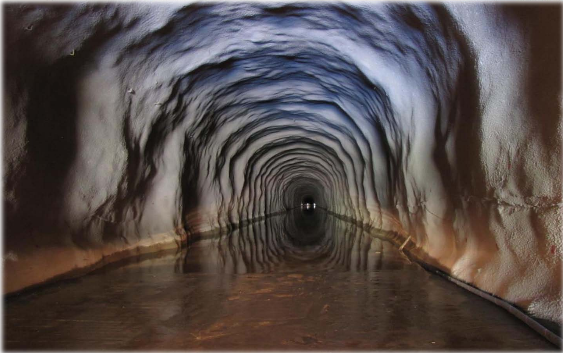
Túnel Cuncas II – Piso executado
