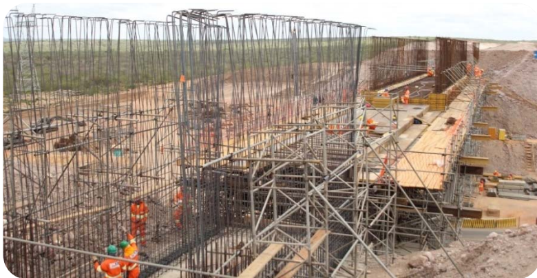
WBS 2304 - Aqueduto BR-316 - Execução da armadura da laje de fundo e das laterais.
