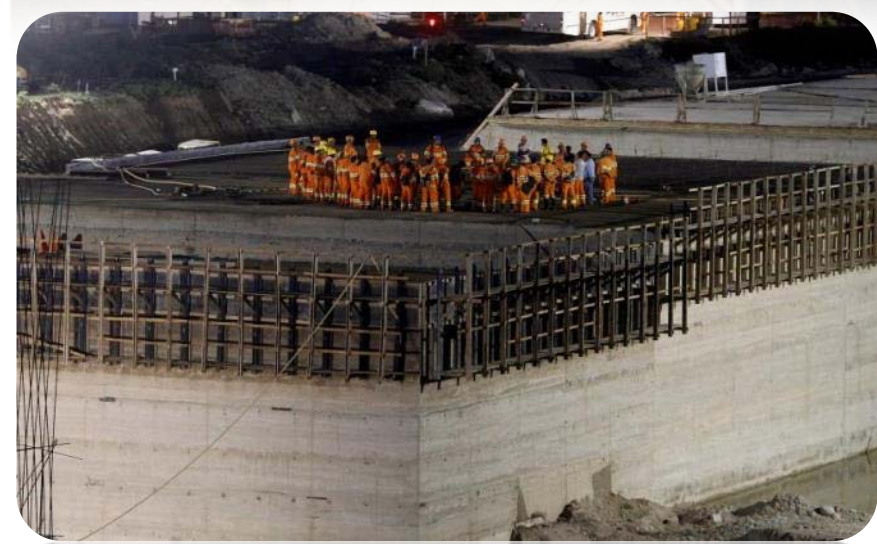
WBS 1113 - Reservatório Porcos - Execução de CCR no vertedouro.
