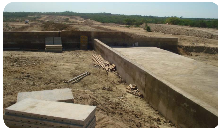
WBS 2110 - Reservatório Bagres - Soleira e muro de proteção do vertedouro.
