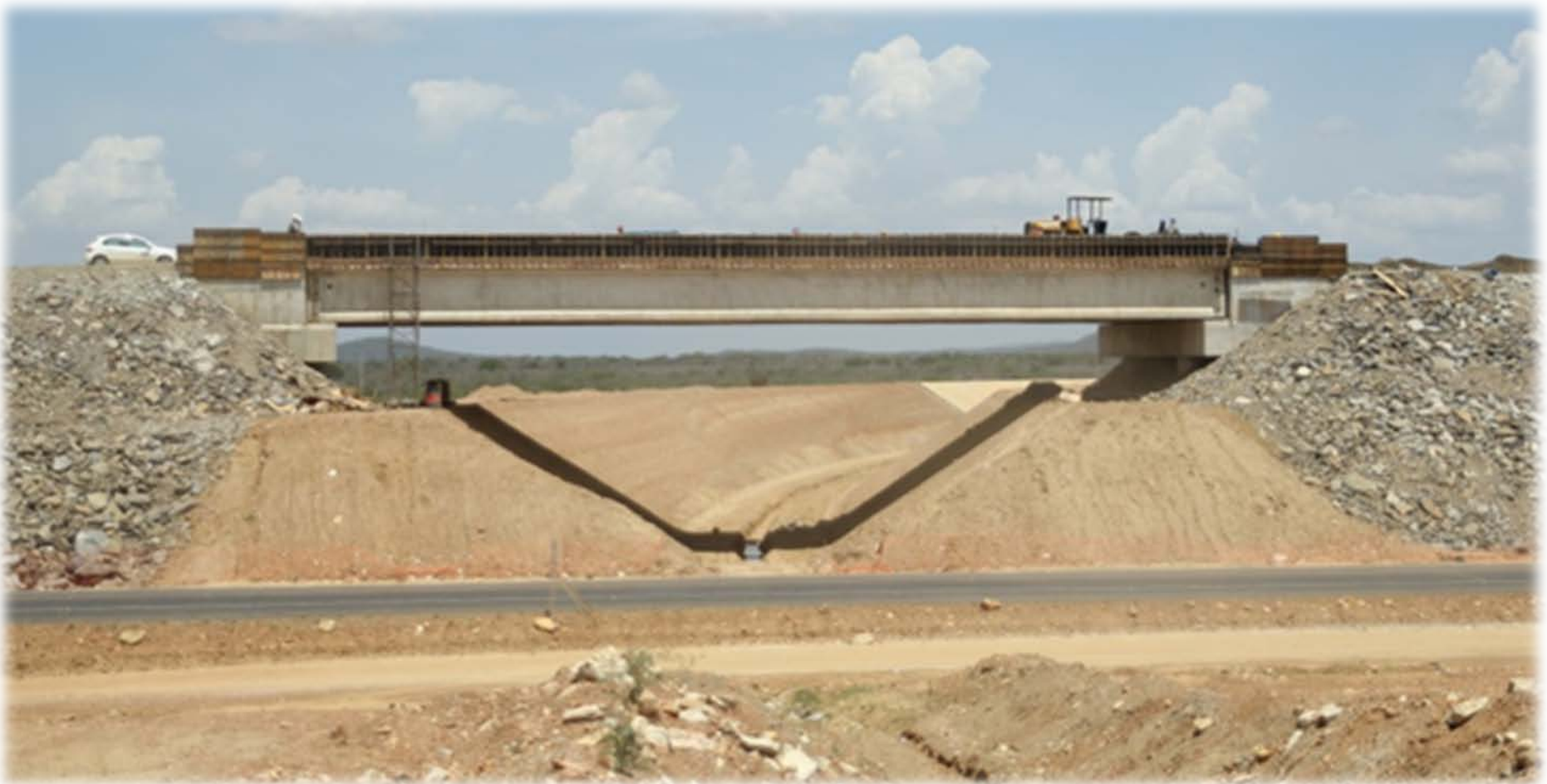
Ponte BR-428 – Execução do canal sob a ponte.
