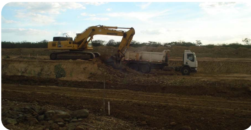
WBS 2110 - Reservatório Bagres - Execução da terraplenagem do maciço do barramento.
