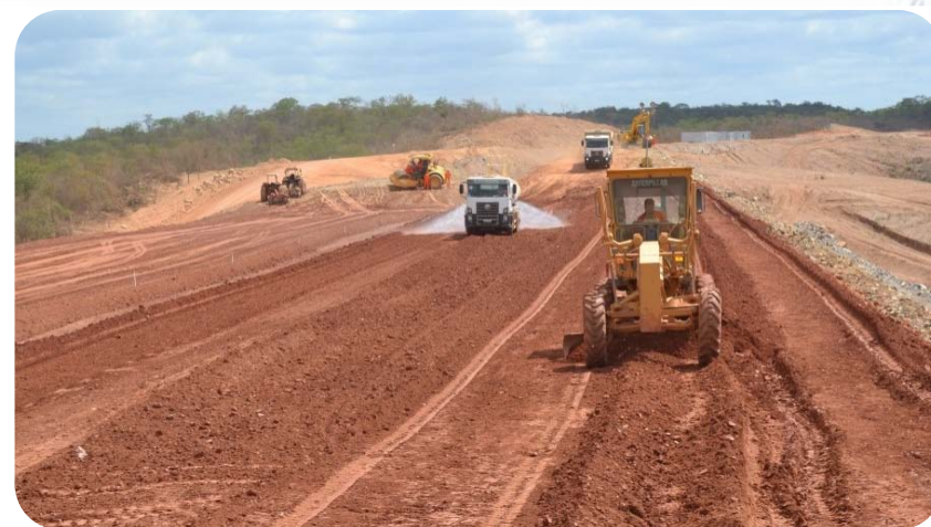
WBS 1219 - Segmento de canal: homogeneização e umectação de aterro na estaca 5014.
