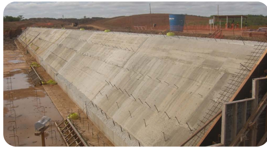
WBS 1111 - Reservatório Jati - Execução do vertedouro.
