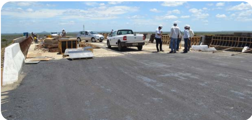
WBS 1505 - Ponte BR-428 - Concretagem do guarda-corpo.
