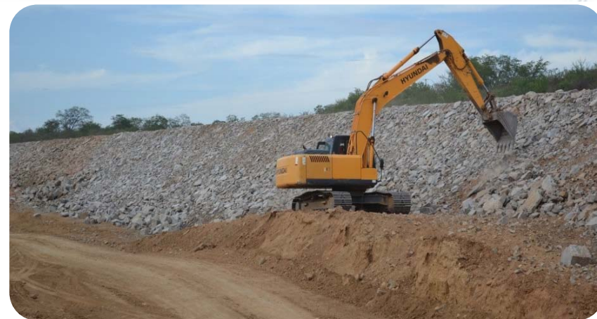
WBS 1215 - - Enrocamento de proteção na estaca 3595.
