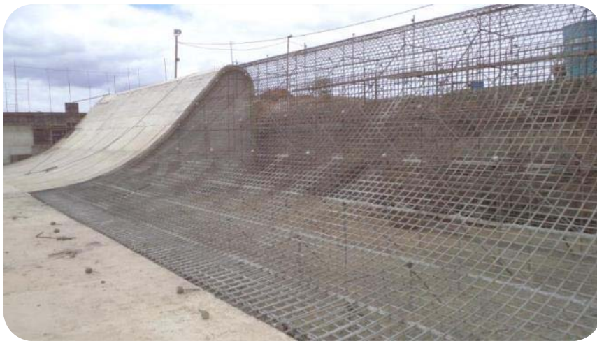
Execução do barramento do Reservatório Mangueira.
