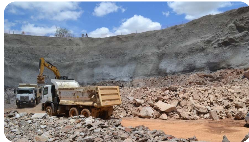
WBS 1403 - Túnel Milagres-Jati - Escavação de material de 3ª categoria
