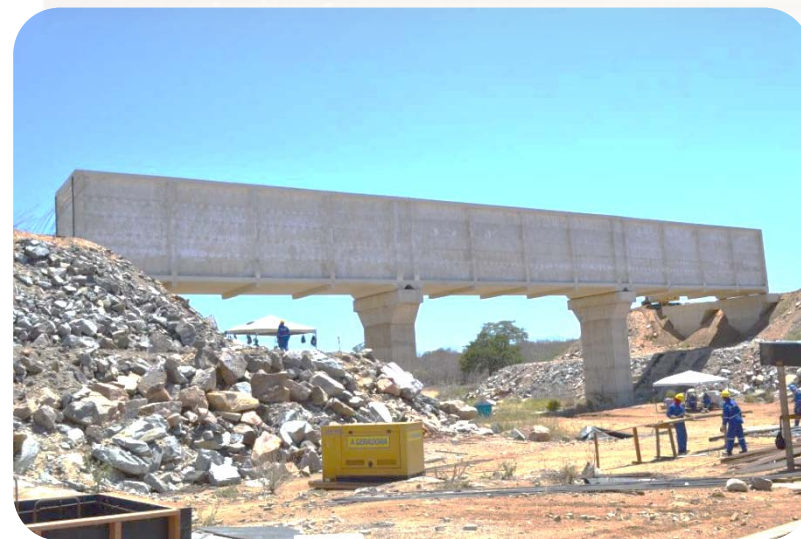
WBS 1306 - Aqueduto Saco da Serra
