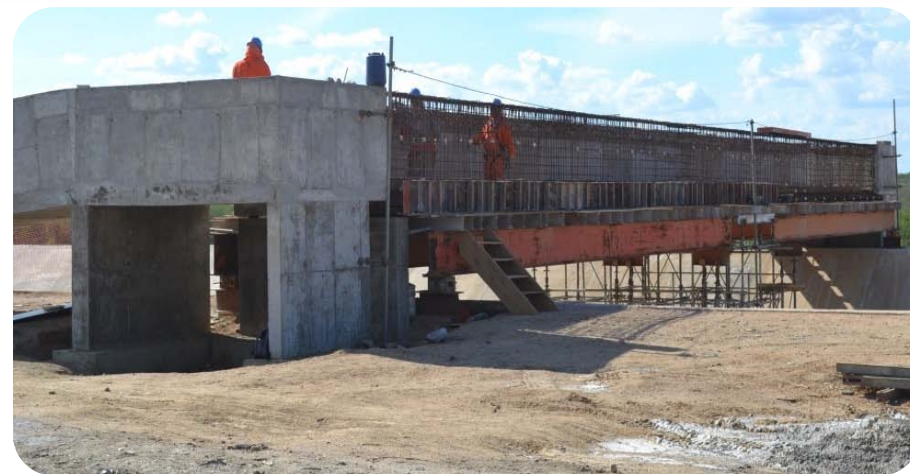
WBS 1556 - Passarela E-1418 - Vista da montagem da forma e armação da viga.
