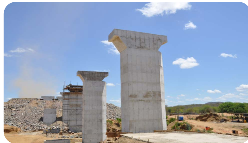
Aqueduto Salgueiro - Execução dos pilares e enrocamento.
