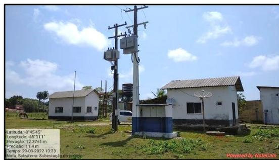
Foto 18 – Subestação de energia da área de captação / tratamento / adução. Salvaterra/PA, em 29.09.2022.
