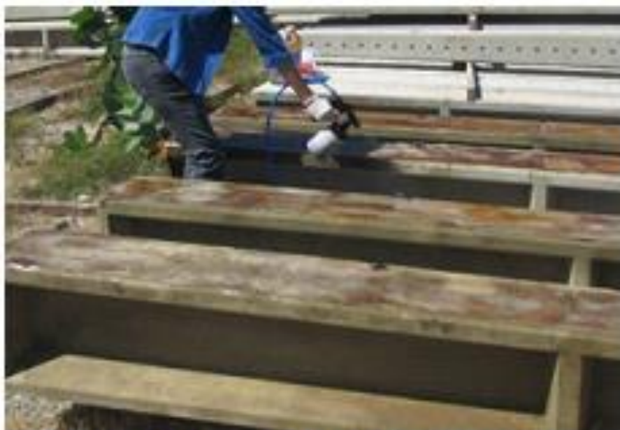
Pintura dos postes com resina
