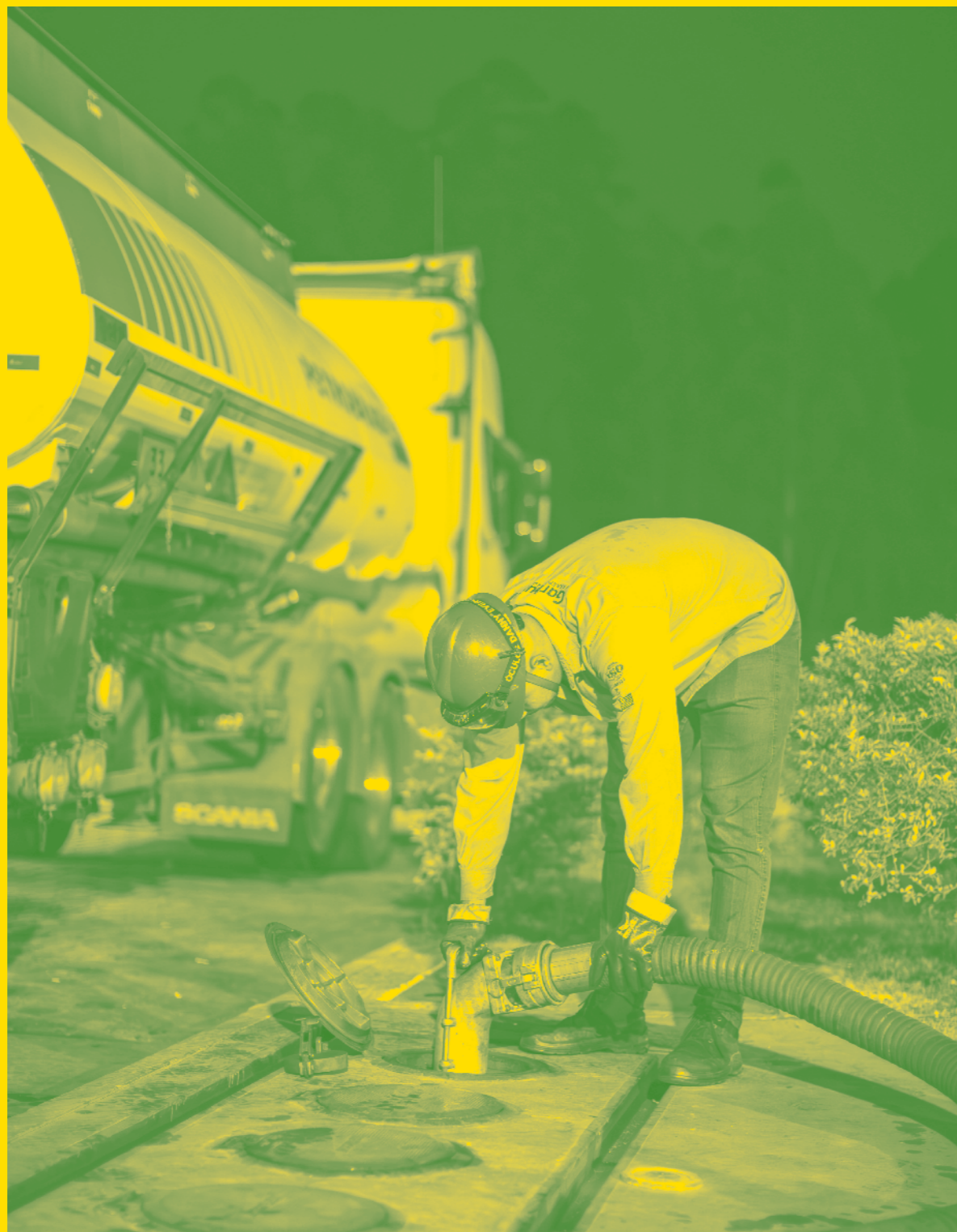
O motorista de caminhão-tanque conduz o combustível com segurança até o posto e realiza a transferência para os tanques subterrâneos, seguindo todos os procedimentos de operação. Com os tanques abastecidos, o posto está pronto para garantir o abastecimento contínuo de veículos.
