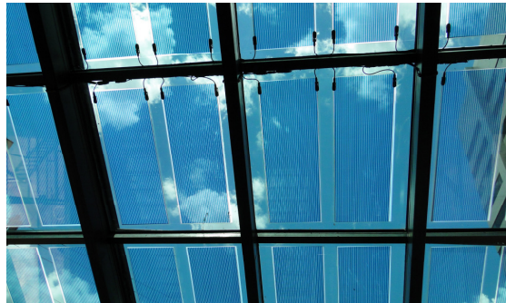
Claraboia solar fotovoltaica em edifício comercial bancário, São Paulo (SP).
