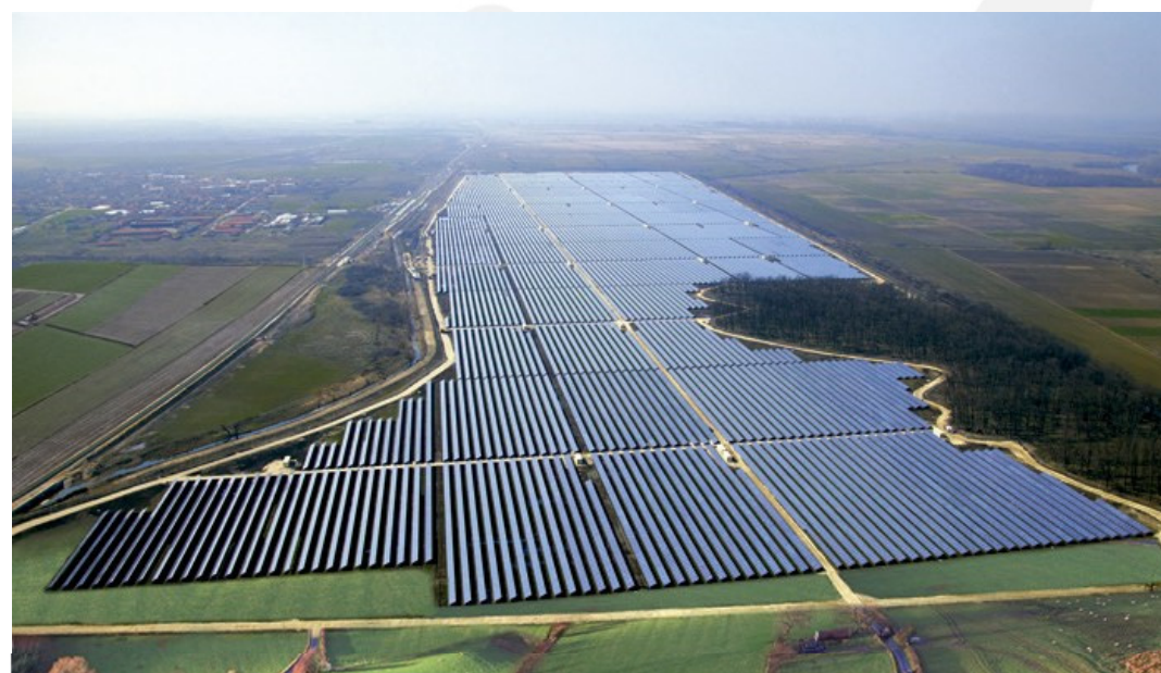
UFV de 225 MWp em Ituverava (BA).
