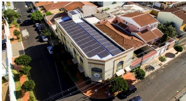
Edifício comercial do segmento farmacêutico, Ribeirão Preto (SP).
