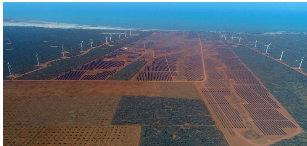
UFV de 101 MWp em Areia Branca (RN).
