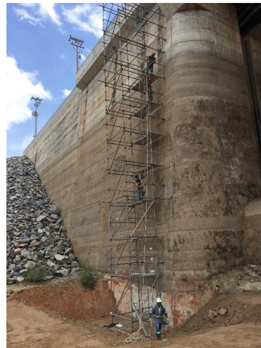
Recuperação da Trinca
