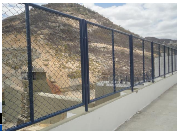
Instalação de alambrados
