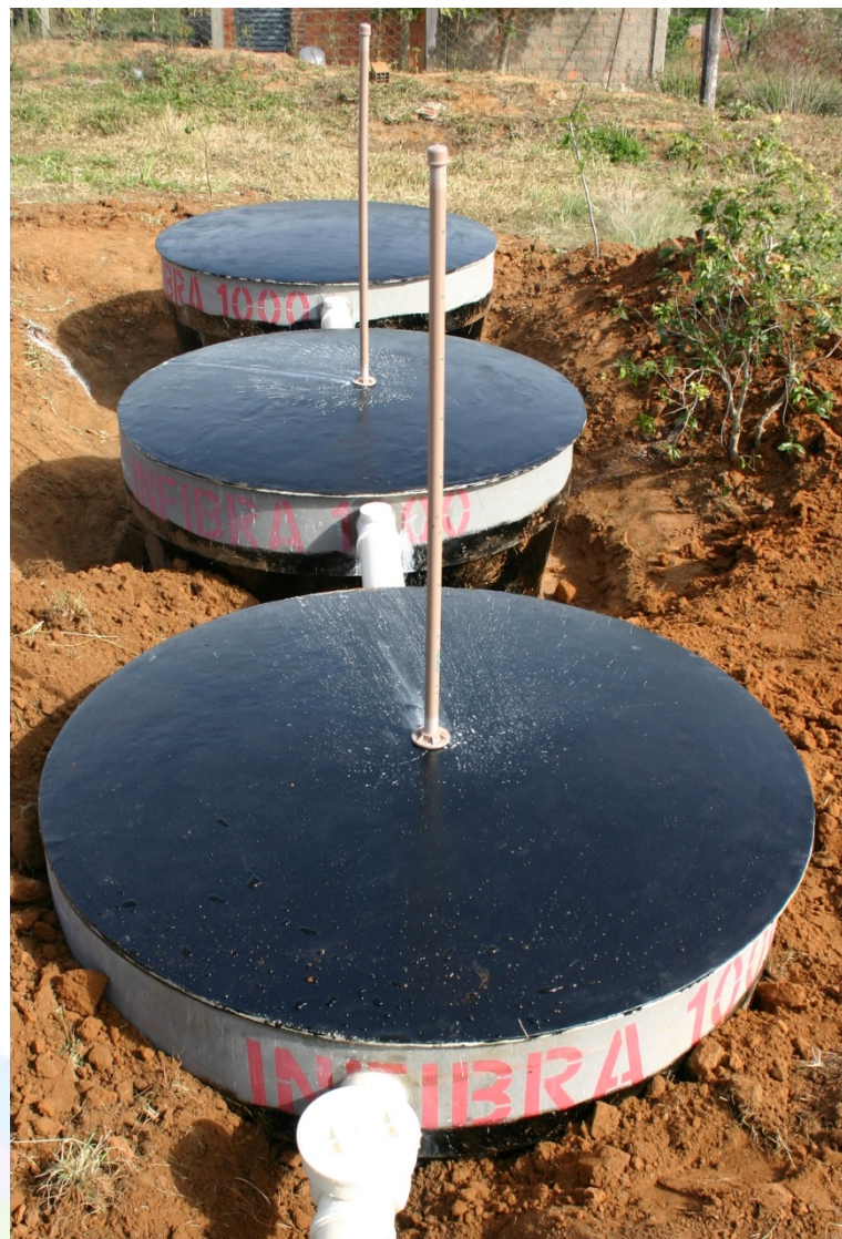
Fossa Séptica Biodigestora com destaque para sistema de alívio de gases. Foto de Valentim Monzane.
