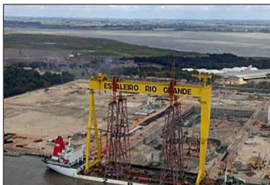
Estaleiro Rio Grande – RS
