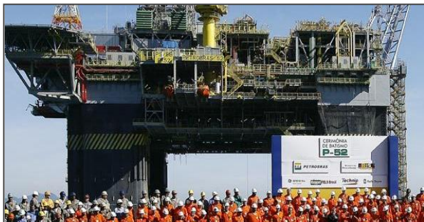
Estaleiro BrasFels – RJ (P-52)
