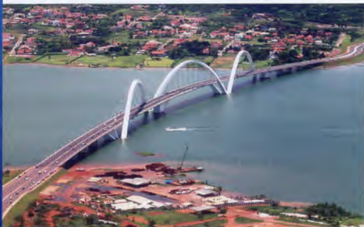
Vista aérea da ponte JK ainda em fase de construção
